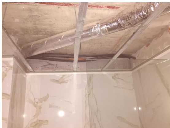
Figura 27 – Tubo flexível de extração de ar instalado
