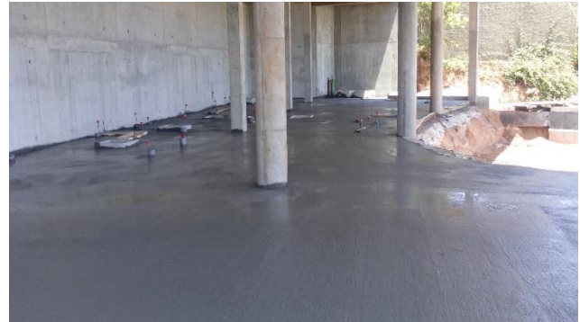
b) Piso térreo executado.
