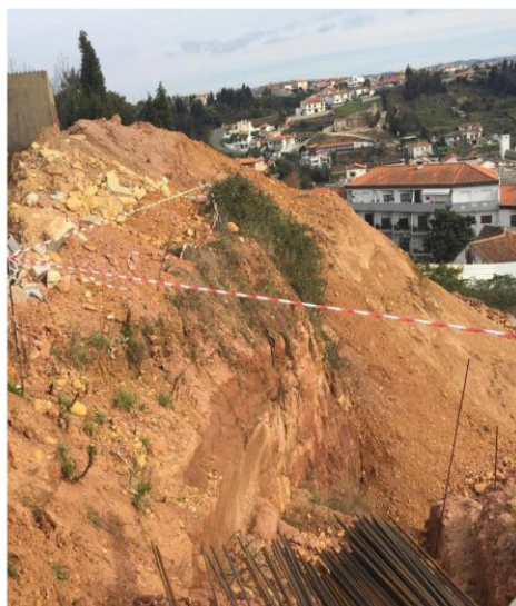
Hotel em Águeda, SPA e Arranjos exteriores Envolventes – Fevereiro de 2015
