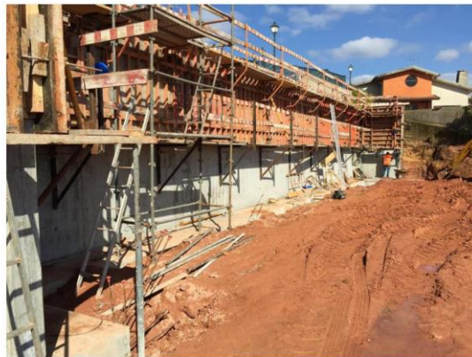
Hotel em Águeda, SPA e Arranjos exteriores Envolventes – Fevereiro de 2015
