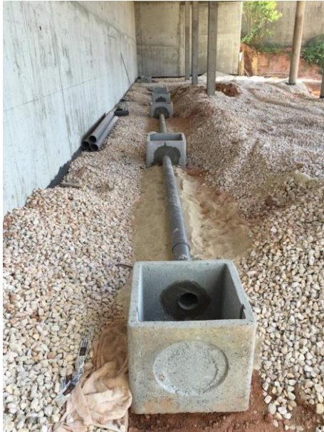
a) Fase de implantação de rede enterrada
