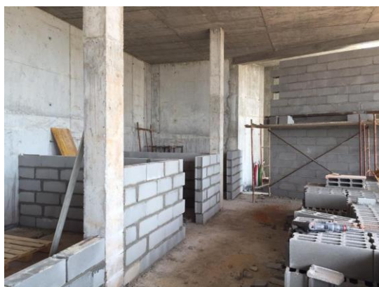
Figura 20 - Paredes interiores de bloco de cimento
