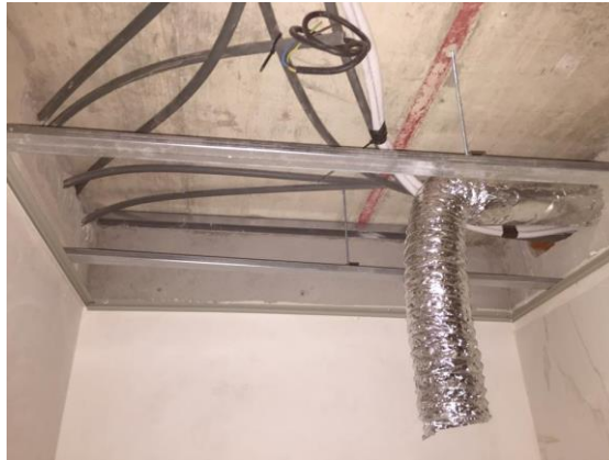
Figura 26 – pré-instalação do tubo flexível de extração de ar
