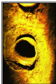
Figura B.9. Fenda corroída entre um tubo laminado de um permutador de calor e uma placa de aço [45] .
