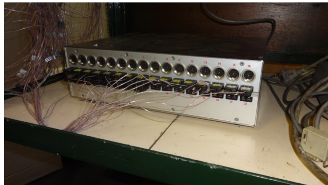
Figura 67: Fios termopar ligados ao terminal.
