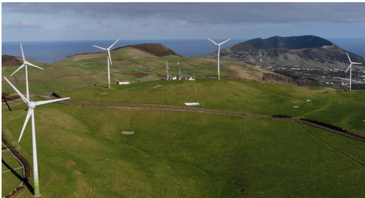
Figura 26 - Fotografia captada por drone, com os 5 aerogeradores da ilha Graciosa
