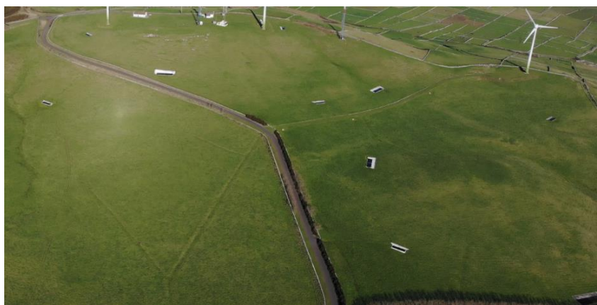
Figura 61 - Tanques de recolha de água da chuva, junto à central eólica da Graciólíca
