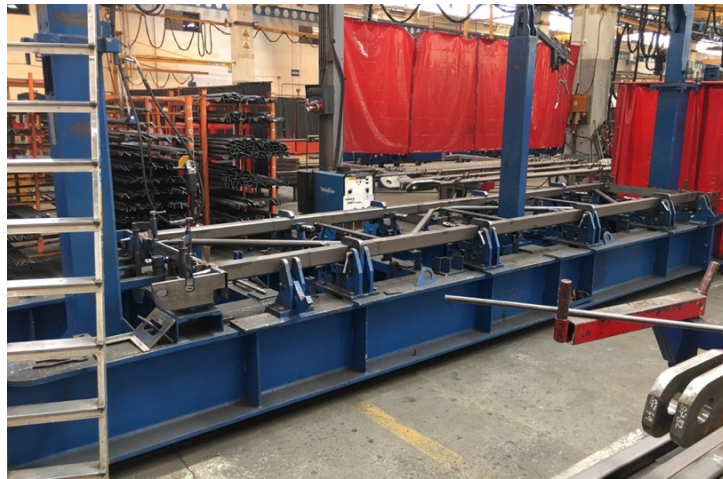
Figura 101 – Montagem da base da Lança de 5m.
