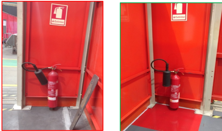
Figura 49 – [A] Extintor (antes) [B] Extintor sinalizado (depois).
