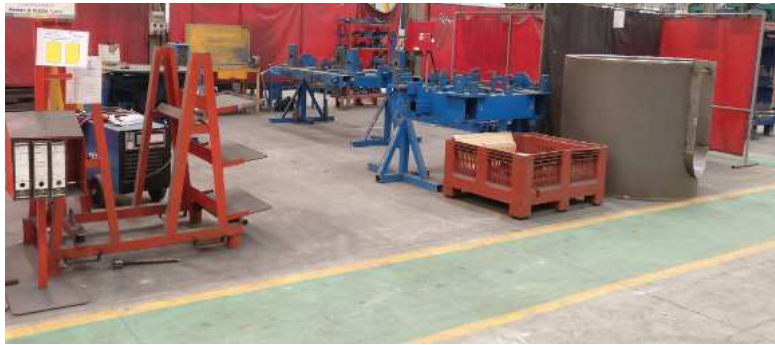
Figura 95 – [A] Piso muito desgastado.
