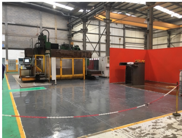
Figura 66 – Pintura do pavimento.
