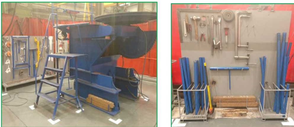
Figura 94 – [A] Bancada inadequada com material obsoleto; [B] Ferramentas obsoletas.
