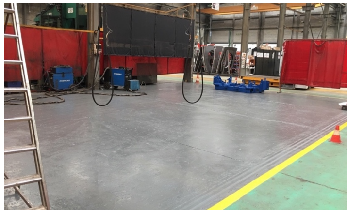
Figura 80 – Pintura do pavimento.
