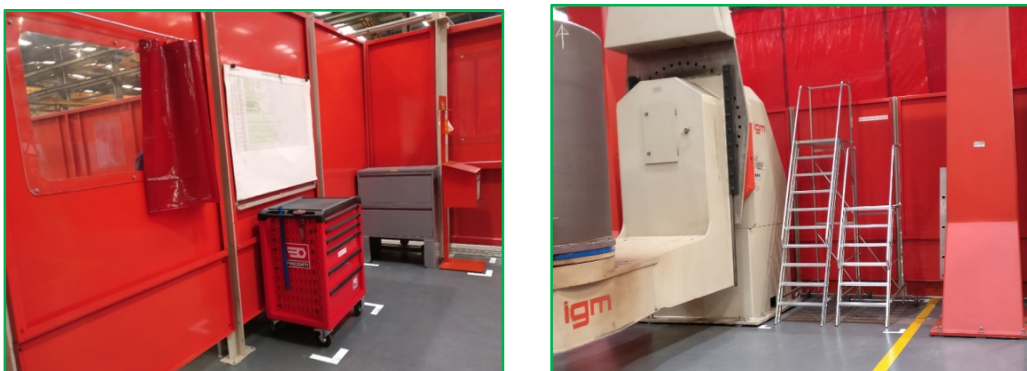
Figura 48 – [A] Pavimento e marcações pintados [B] Local para acessórios de elevação definido.
