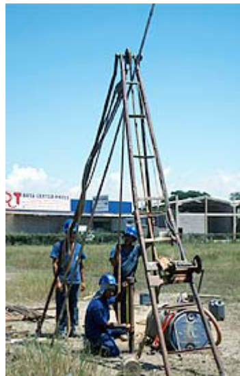
Figura 48 – Execução de ensaio SPT.
