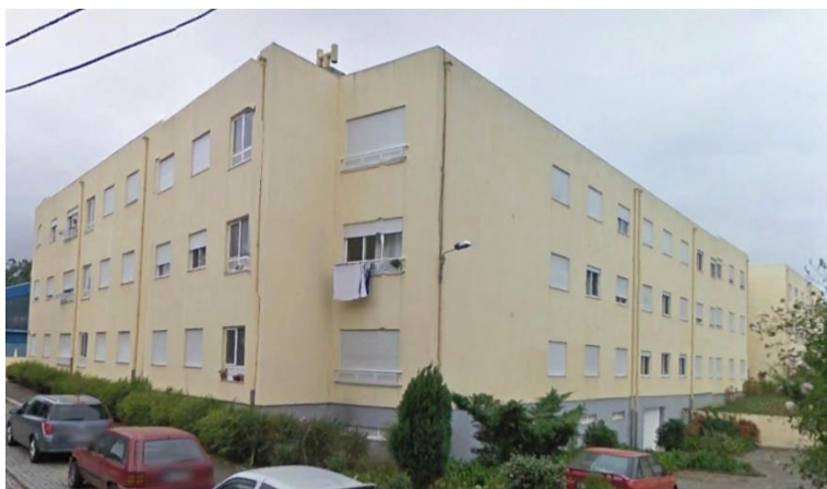
Figura 2.6 – Edifício Padre Américo, Canelas, Vila Nova de Gaia
