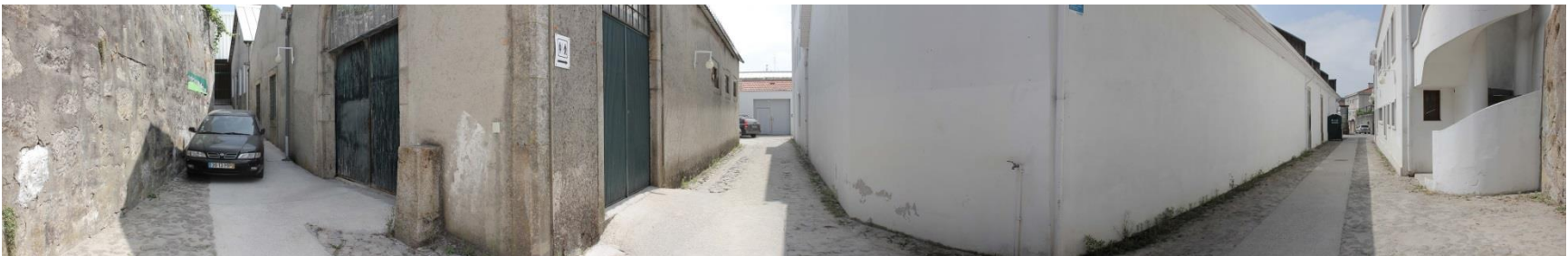
Figura 64 - Imagem panorâmica rua lateral da fundação – 180°
