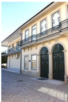
Figura 1 - Edifício principal da Academia de Música de Castelo de Paiva. Retirado de: https://www.averdade.com/2012/10/04/castelo-de-paiva-cmara-vai-atribuir-prmio-de-mrito-ao-melhor-aluno-da-academia-de-msica/
