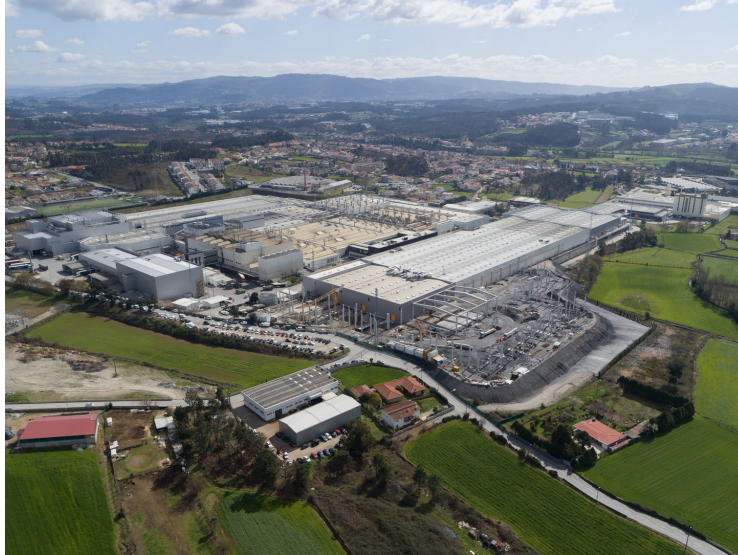
Figura 1.1: Instalações da Continental Mabor em Lousado [2]
