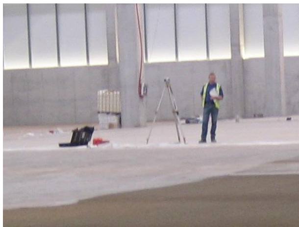
Fig. 84 Acompanhamento topográfico diário da execução dos pavimentos dos armazéns.
