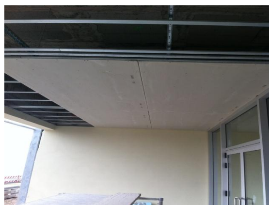
Fig. 27 Teto exterior em Aquapanel.
