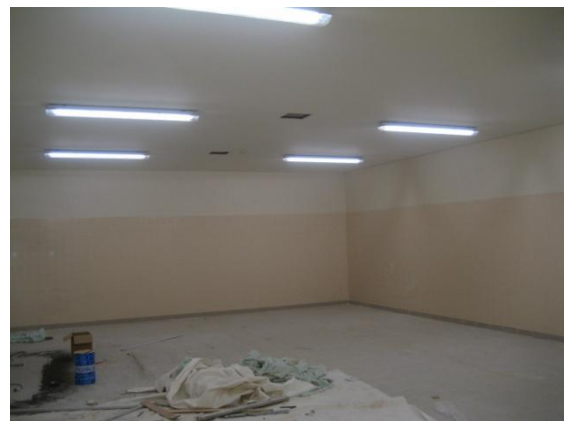
Fig. 23 Teto de gesso cartonado hidrófugo concluído.
