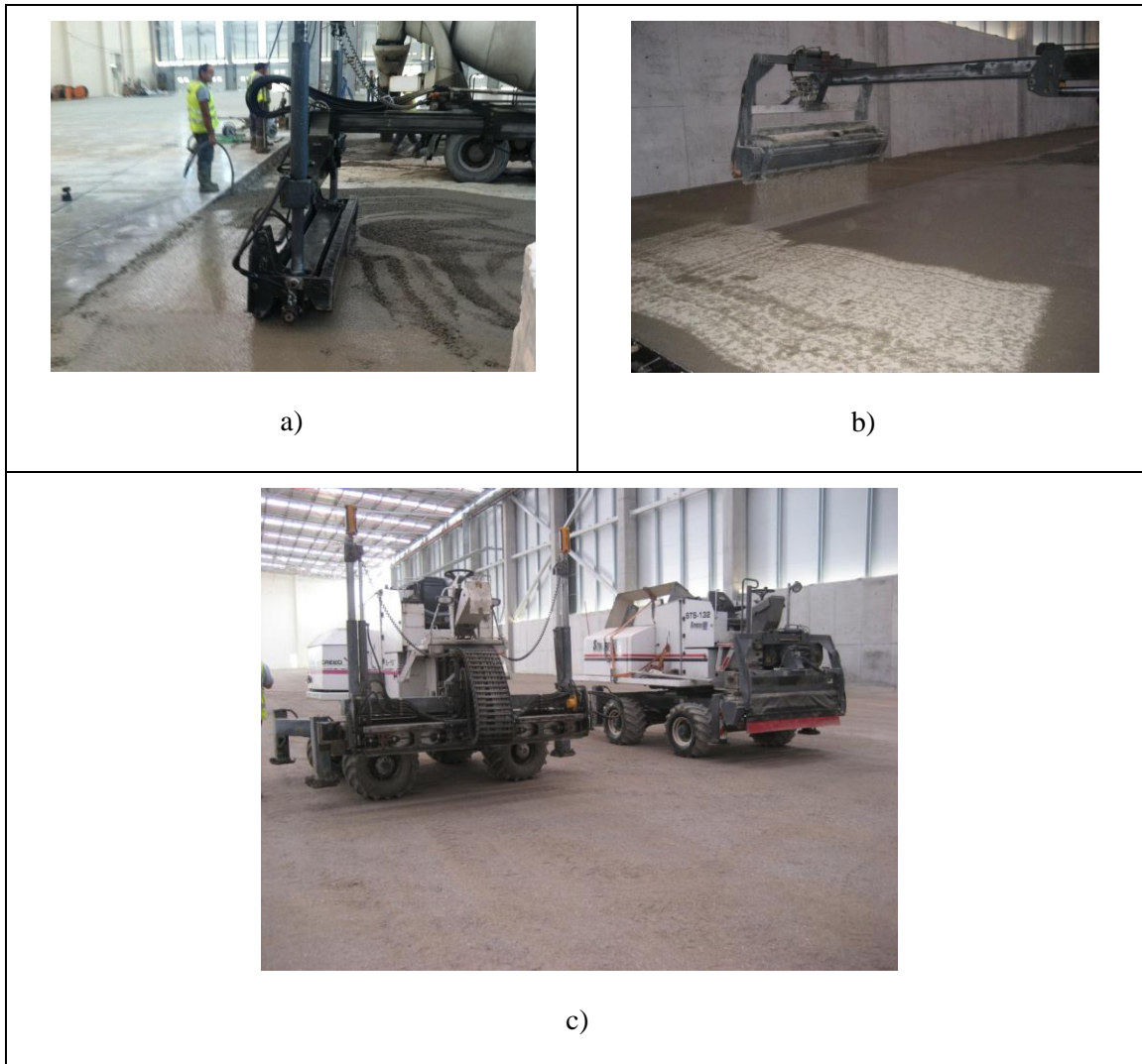
Fig. 89 a) Espalhadora automática de betão b) Espalhadora de endurecedor de superfície c) Os 2 equipamentos.
