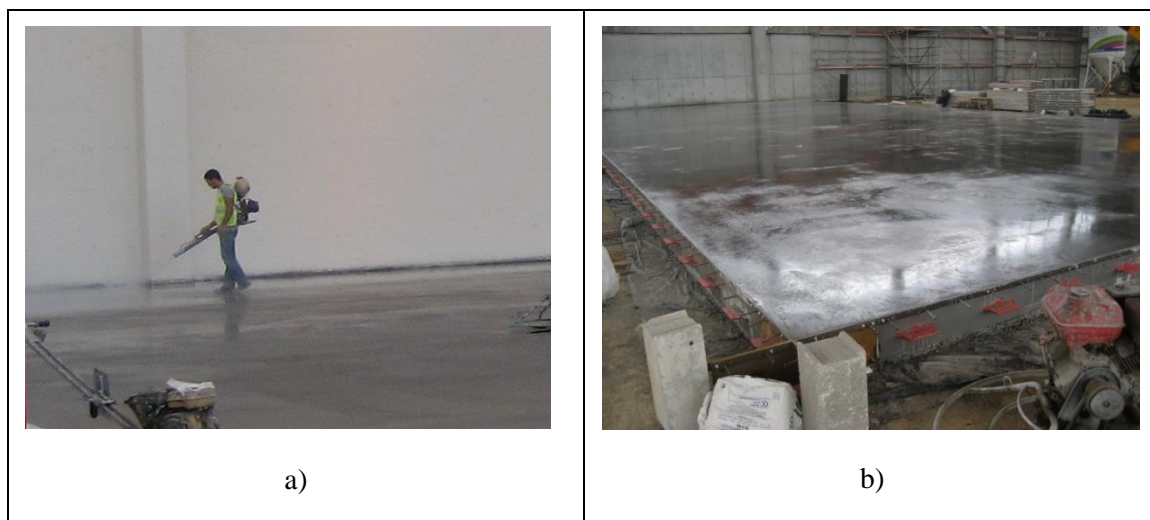
Fig. 92 a) Pulverização da superfície do pavimento com produto de cura do betão. b) Secção de pavimento 24h após a conclusão.
