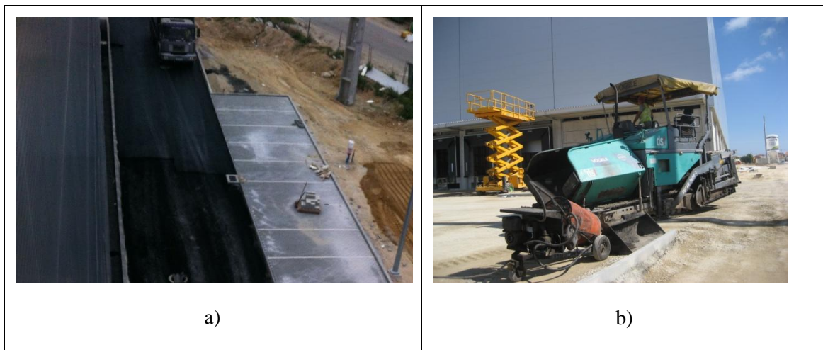
Fig. 126 a) Espalhamento das camadas de macadame b) Espalhadora de betuminoso.
