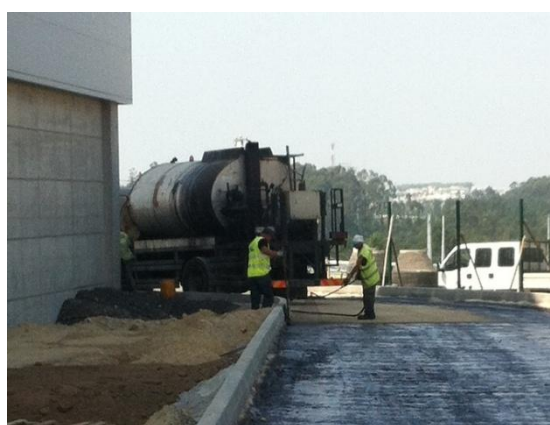
Fig. 125 Execução de rega de impregnação.
