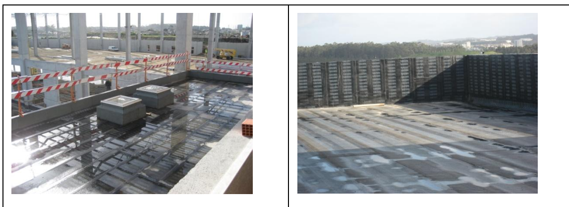
Fig. 12 Colocação de telas asfálticas na cobertura do edifício de apoio.
