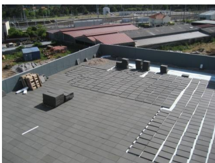
Fig. 16 Colocação de lajetas sobre pinos plásticos.
