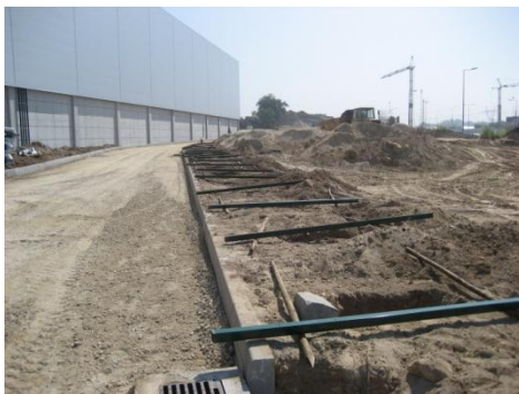
Fig. 113 Alinhamento de Lancil colocado no alçado Sul.
