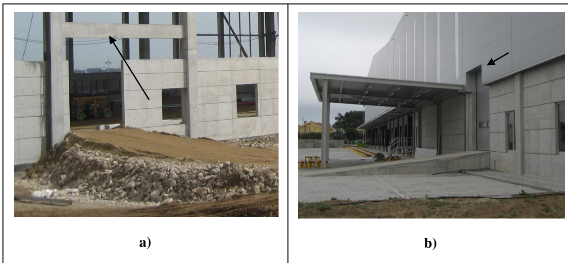
Fig. 109 Alteração do portão de acesso ao exterior do Armazém A a) Viga de apoio à estrutura dor portão b) Portão concluído com alteração no revestimento de fachada.
