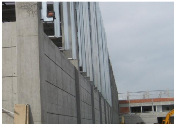
Fig. 61 Alinhamento da estrutura de suporte dos painéis de fachada.
