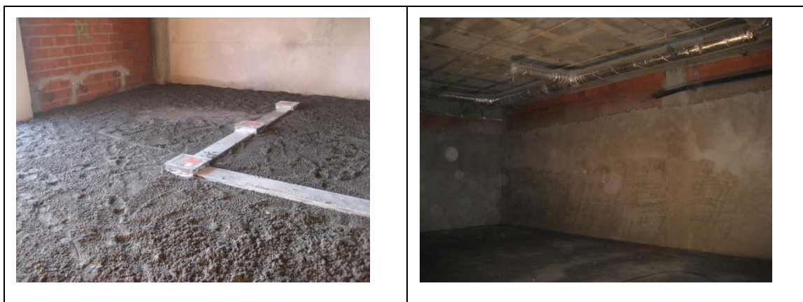
Fig. 11 Execução de betonilha de enchimento em pavimentos interiores.
