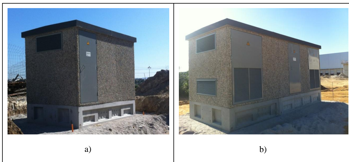
Fig. 105 a) Posto de seccionamento- PS b) Posto de transformação PT.
