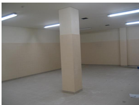
Fig. 29 Revestimento cerâmico no vestiário.
