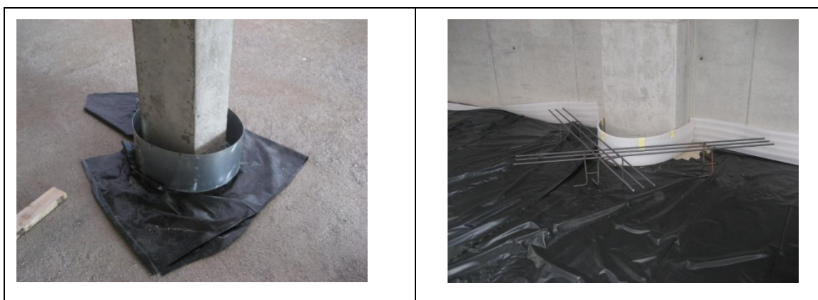
Fig. 86 Cofragem circular perdida e armadura de reforço utilizados na contenção da fissuração em volta dos pilares.
