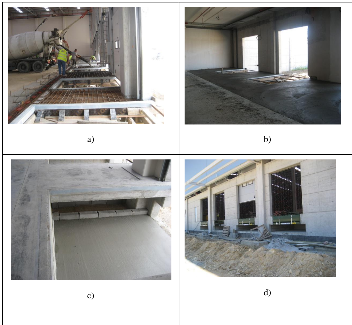
Fig. 99 Cais de descarga a) Betonagem b) Imagem da junta de betonagem c) Betonagem a cota inferior da zona da plataforma niveladora d) Plataforma niveladora.
