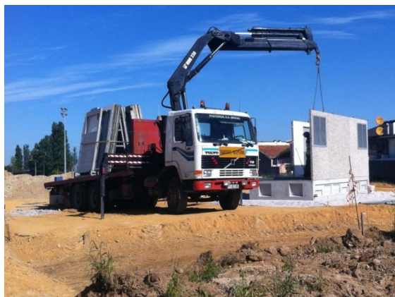
Fig. 103 Transporte do PT e colocação em obra.
