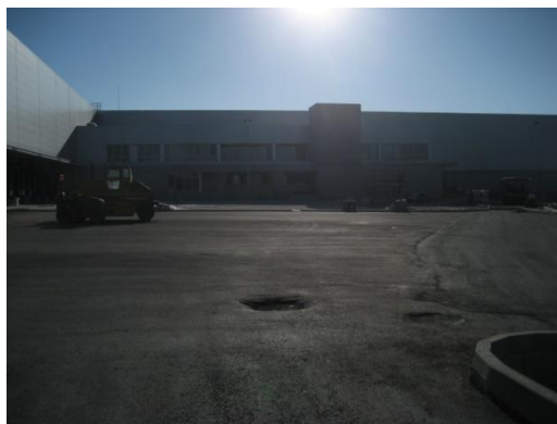
Fig. 121 Camada de ligação em camada de macadame betuminoso.
