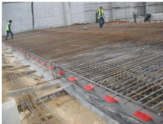
Fig. 102 Secção de pavimento do túnel de acesso ao edifício de apoio antes da betonagem.
