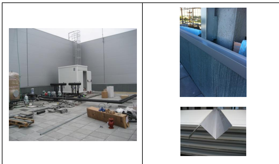
Fig. 73 Remate da fachada dos armazéns com murete do edifício de apoio na cobertura.
