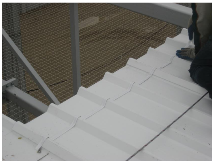
Fig. 52 Aplicação da fita butilo de estanquidade da junta entre painéis.
