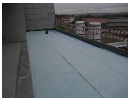
Fig. 15 Manta geotêxtil de proteção.
