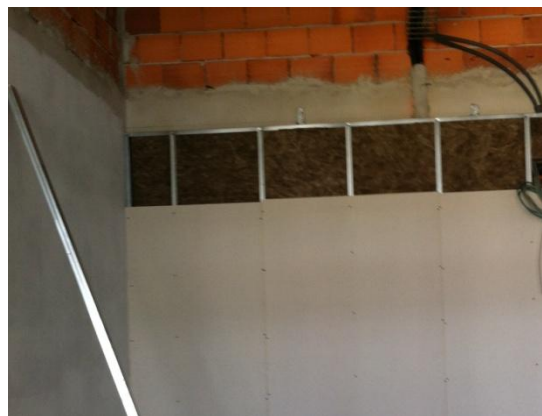
Fig. 25 Placagem e isolamento de paredes em gesso cartonado.
