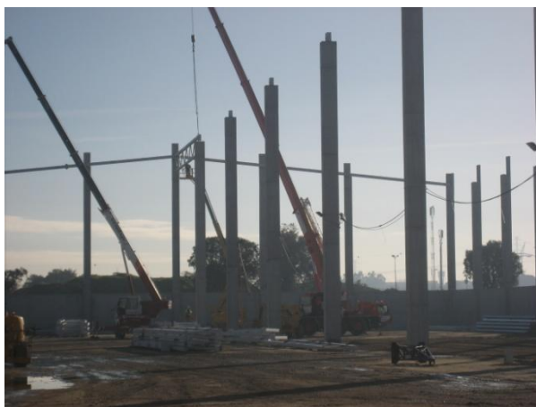
Fig. 40 Elevação da estrutura metálica com camião grua.
