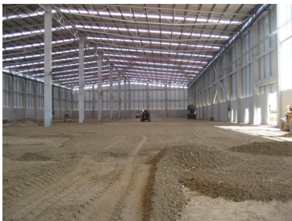
Fig. 76 Execução da 1ª camada de base em AGE no Armazém A.
