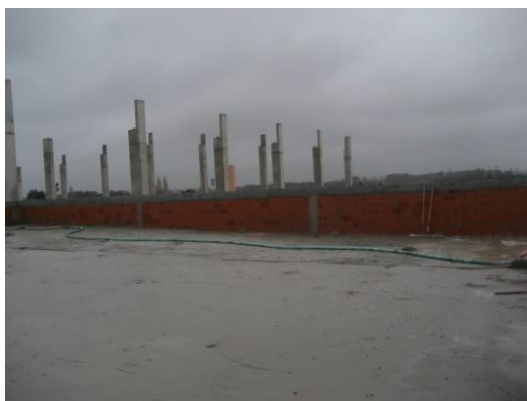
Fig. 10 Revestimento da cobertura com betão celular.
