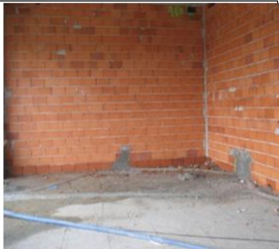
Fig. 9 Rede elétrica embebida em paredes e pavimentos.
