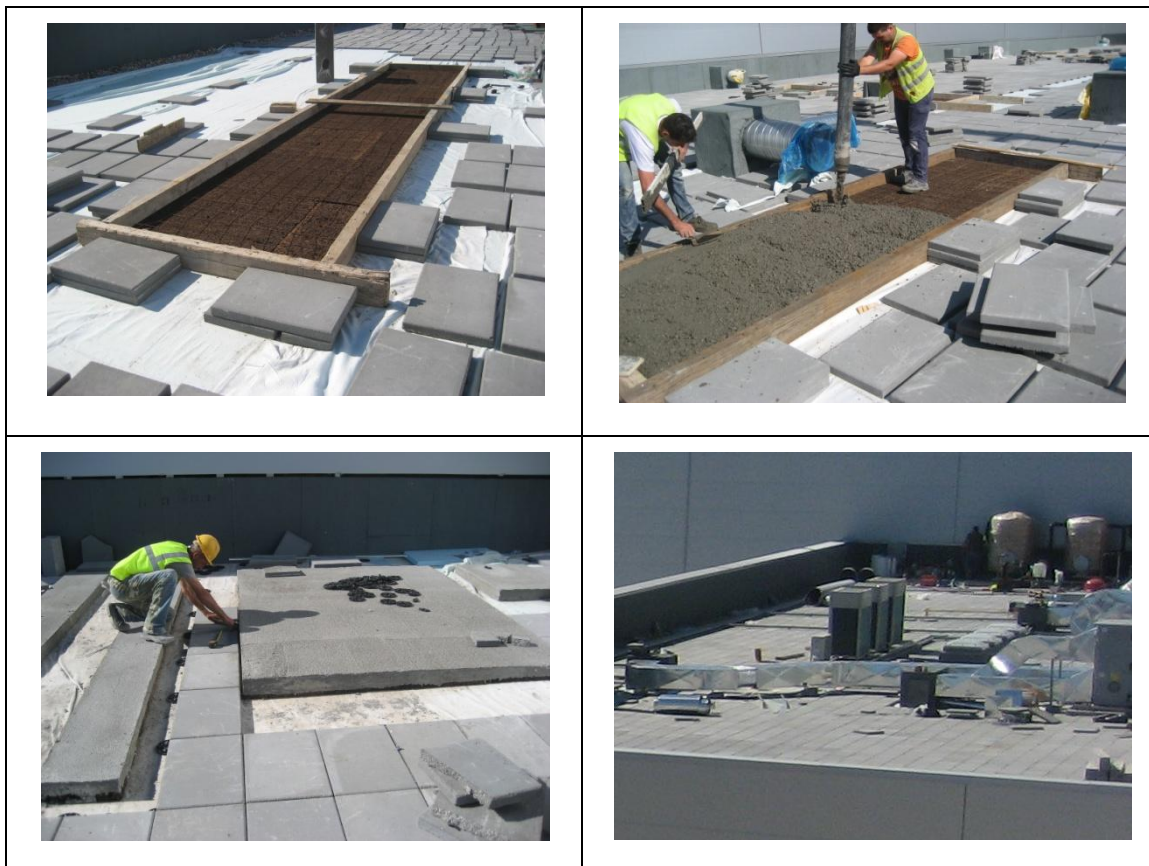
Fig. 19 Execução de maciços para instalação de equipamentos na cobertura do Edifício de Apoio.
