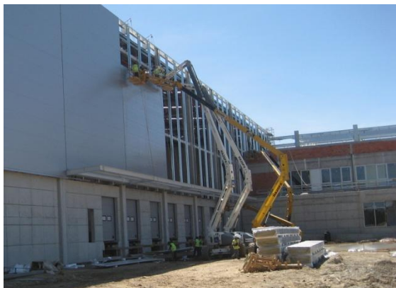
Fig. 62 Montagem do painel de fachada.
