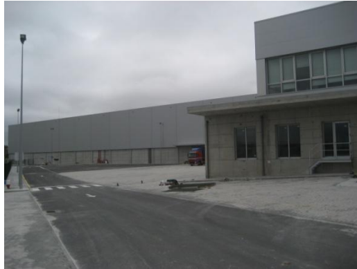
Fig. 122 Camada de desgaste em betão betuminoso.
