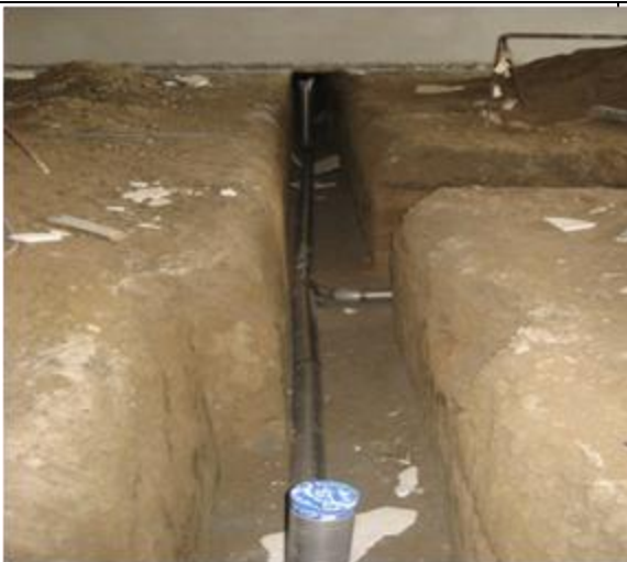
Fig. 8 Vala de infraestrutura em pavimento interior.
