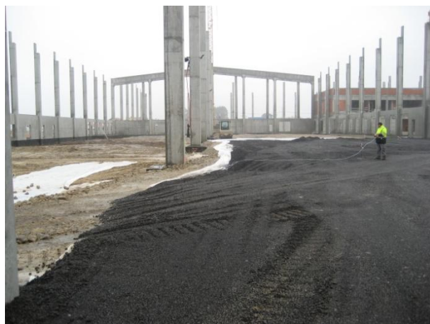
Fig. 78 Utilização do ASIC na sub base do pavimento do Armazém A.
