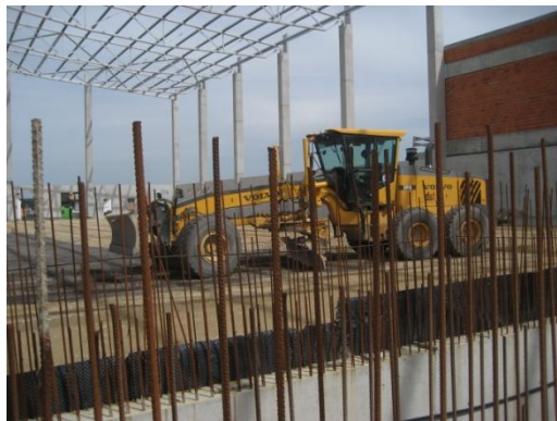
Fig. 101 Túnel de acesso ao edifício de apoio.
