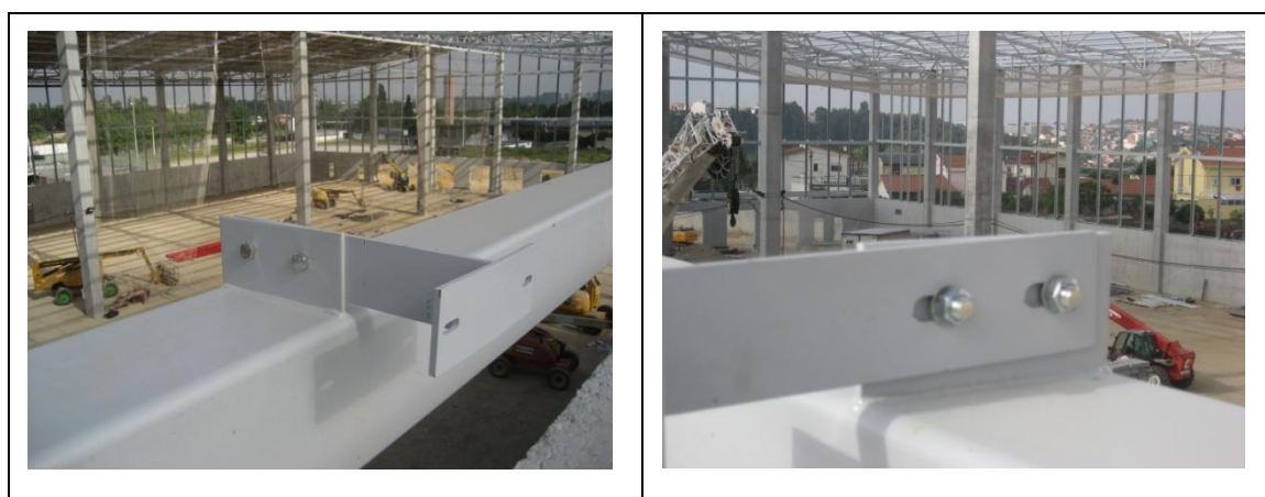
Fig. 59 Peça de ligação de estrutura metálica das fachadas para fixação das madres Max.
