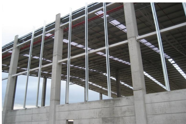
Fig. 45 Estrutura de fachada.
