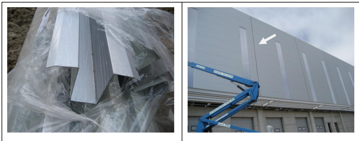
Fig. 69 Juntas verticais entre painéis de fachada.
