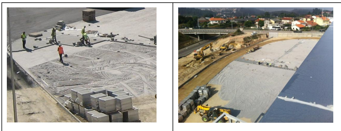
Fig. 114 Assentamento de blocos de betão UNI.
