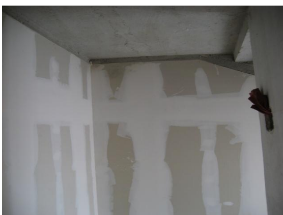
Fig. 26 Emassamento de paredes em gesso cartonado.
