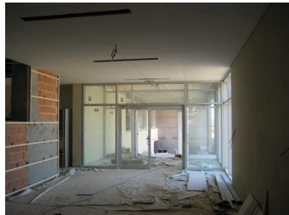
Fig. 21 Placagem de teto de gesso cartonado.
