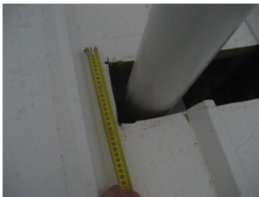
Fig. 55 Atravessamento do painel de cobertura pela estrutura de suporte dos painéis solares.
