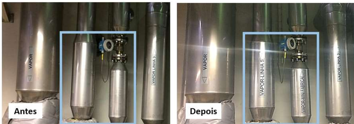
Figura 4.4 – Colocação de identificação em tubagem sem identificação
