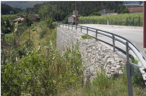
Fotografia 23 - Muro de Suporte M2
