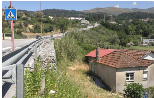
Fotografia 24 - Muro de Suporte M2
