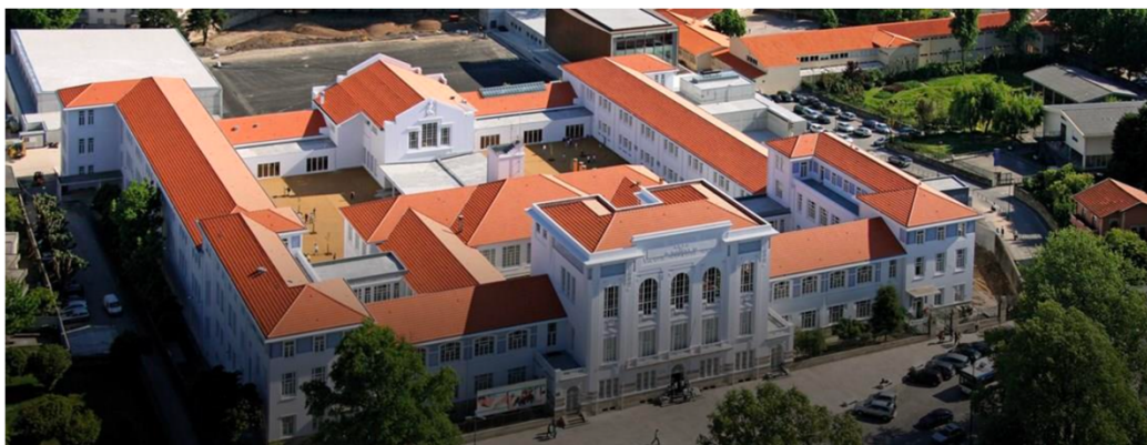
Figura 1 - Vista Aérea Conservatório de Música do Porto e Escola Básica e Secundária Rodrigues de Freitas (retirada galeria de imagens do website do Conservatório).
