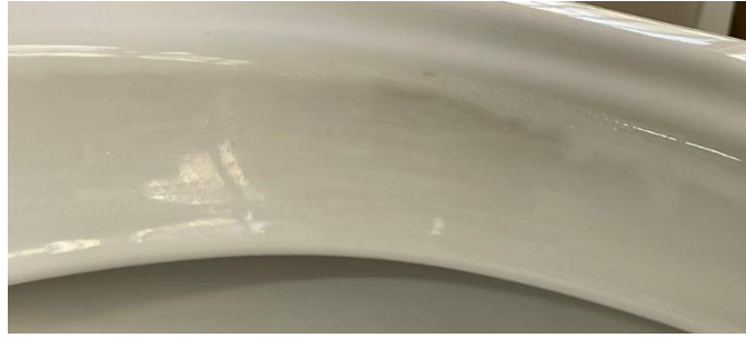
Figura 3.6 – Falta de vidro no arco de uma bacia.
