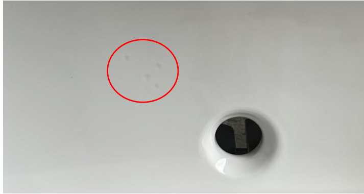
Figura 3.3 – Pia de lavatório com depressões
