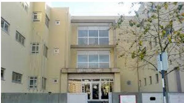
Figura 19 - Instalações do ACeS de Gondomar
