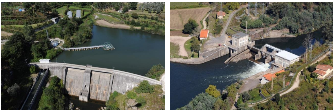
Figura 7 Fotografias das centrais de Guilhofrei e Penide, albufeira e fio de água respetivamente [11][12]
