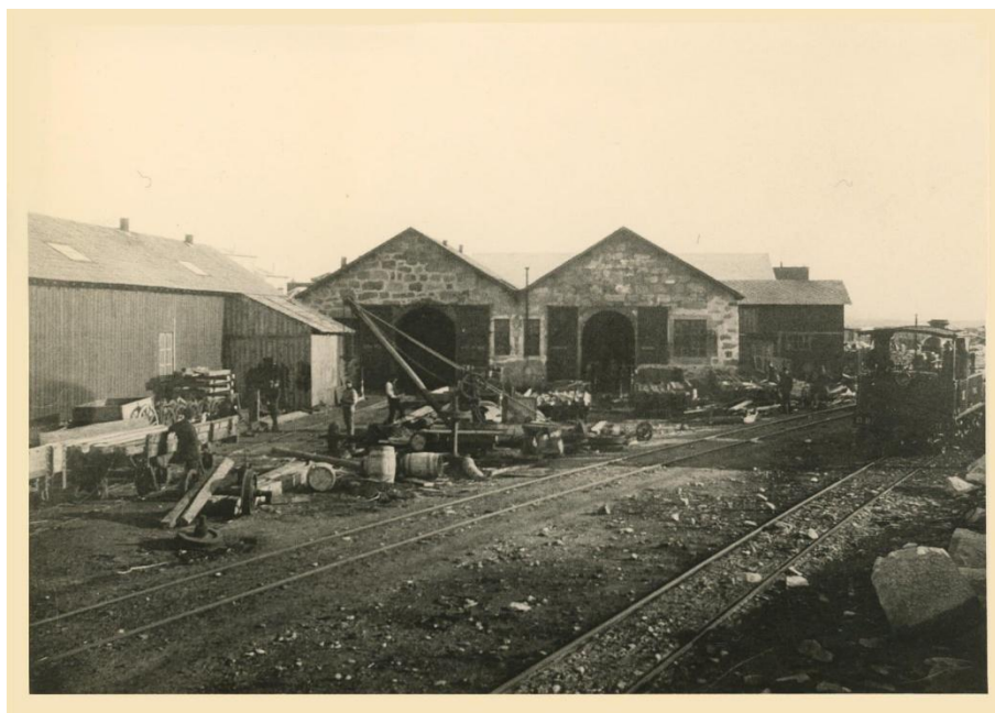
Figura 4 – Construção do Porto de Abrigo de Leixões, datado entre 1884-1892.
