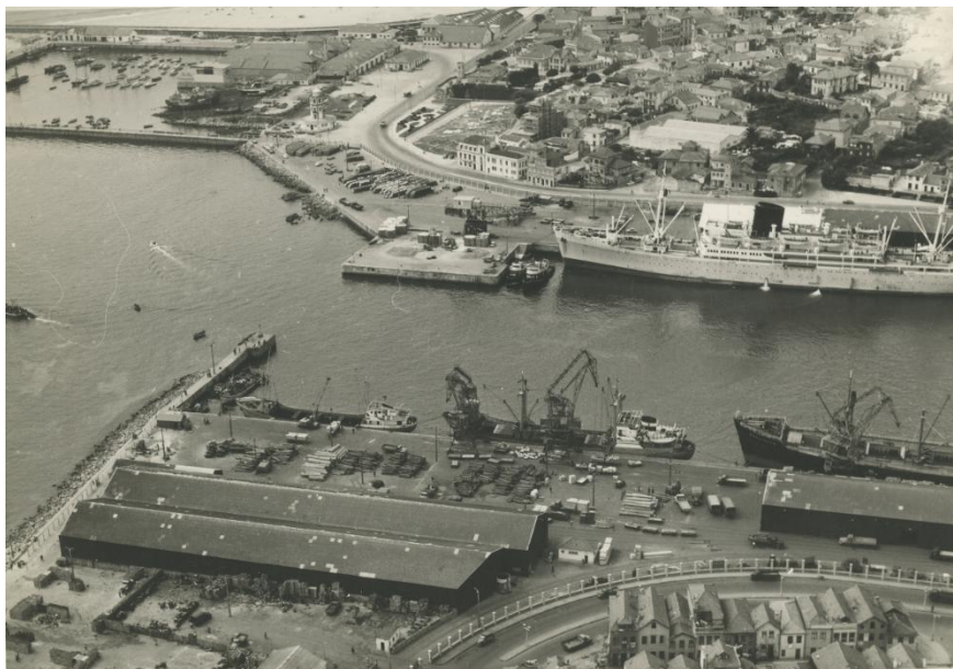
Figura 3 – Navio atracado ao lado da estação de passageiros e vista aérea da área envolvente, 1964.
