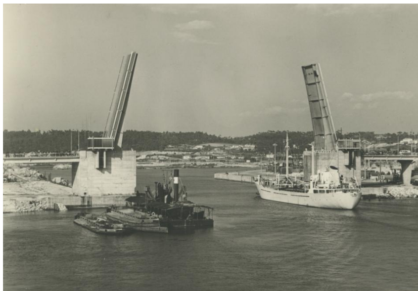
Figura 3 – Antiga Ponte Móvel, 27 de maio de 1963.
