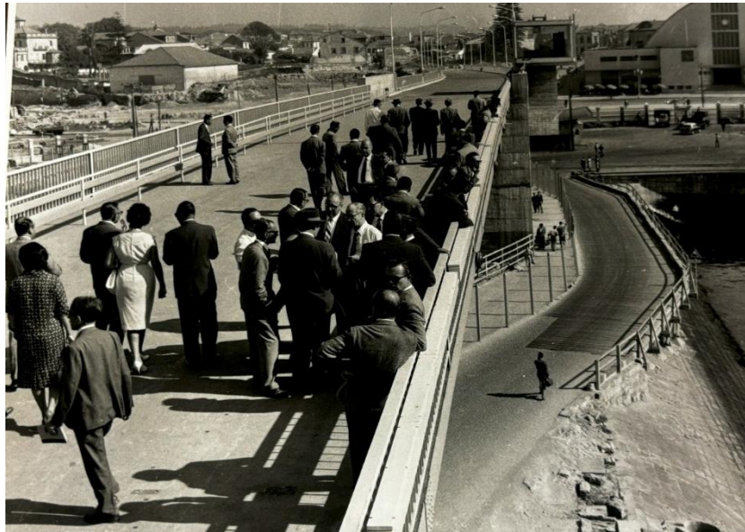
Figura 10 – Inauguração da Ponte Móvel em 1961.
