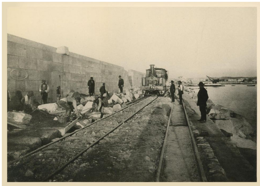
Figura 5 – Construção do Porto de Abrigo de Leixões, datado entre 1884-1892, utilizando a via férrea.
