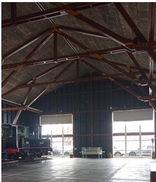
Figura 26 – Interior da estação de passageiros, imagem de 2023.
