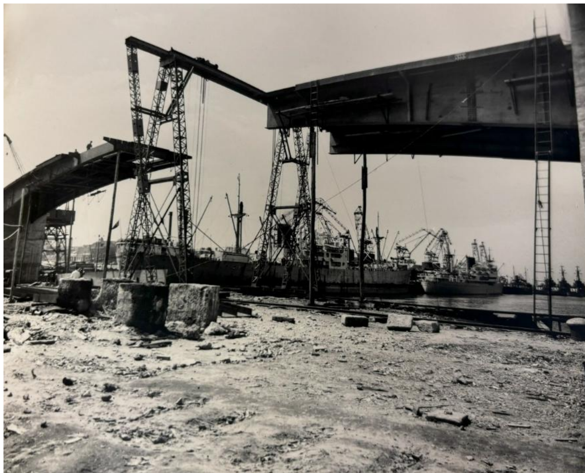
Figura 1 – Construção da Ponte Móvel, 1958.
