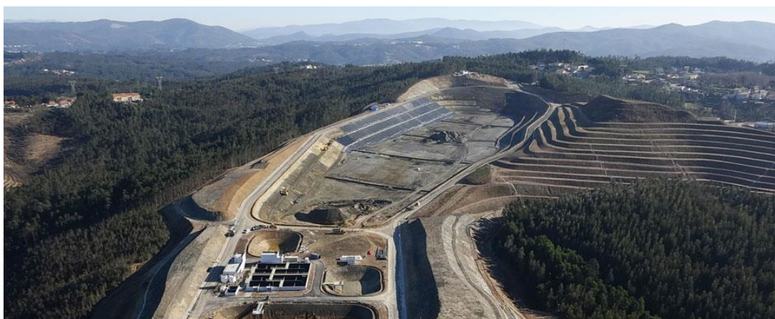
Figura 3.5 - Instalações do novo aterro da Suldouro (Suldouro, 2015)
