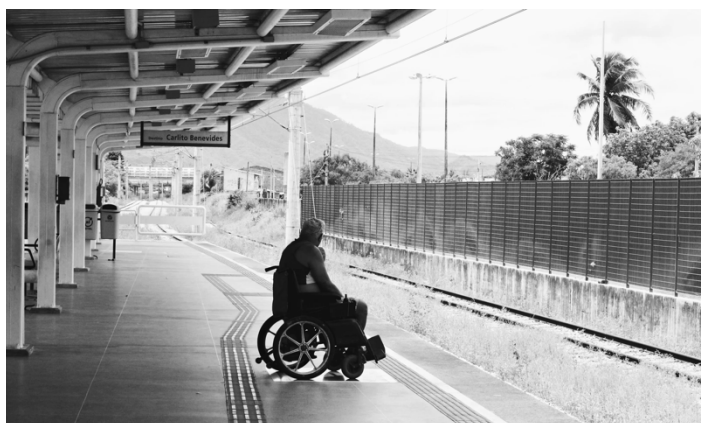
Figura 9 - Estas faixas em alto-relevo, quando fixadas ao chão, auxiliam na mobilidade autónoma de pessoas com algum tipo de deficiência visual
