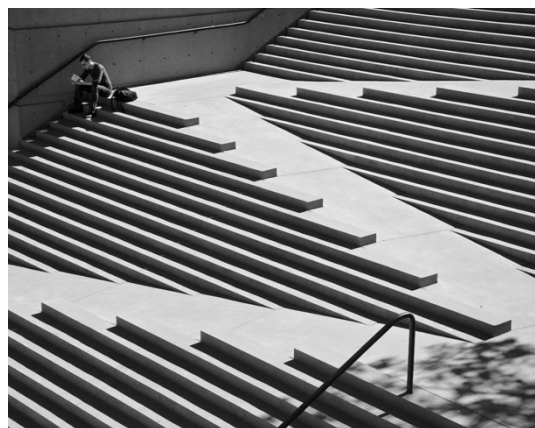
Figura 11 - Rampas de acesso para pessoas com mobilidade reduzida
