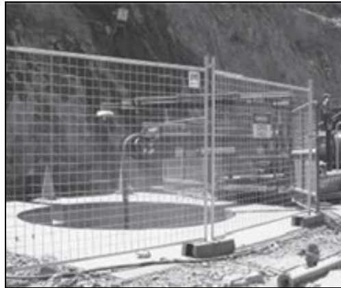
Figura 3. Vedação física à volta da boca do poço (adaptado de Ford et al., 2010).
