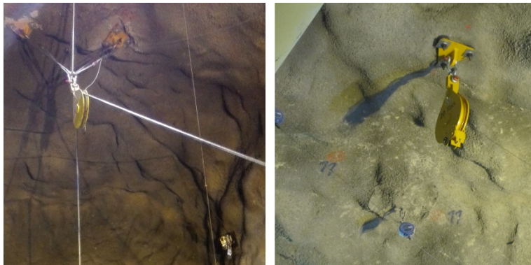
Figura 56. Fixação da roldana para o caço de aço (arquivo de fotos EPOS SA; com autorização).
