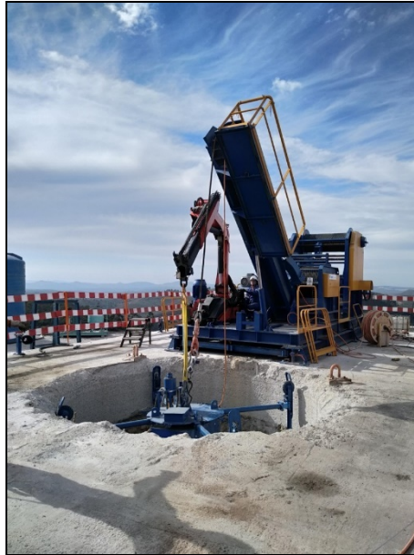
Figura 21. Colocação do robot de projeção no poço auxiliado pela grua (arquivo de fotos EPOS SA; com autorização).
