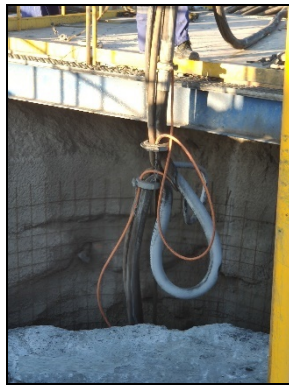
Figura 59. Afrouxamento de uma abraçadeira técnica (arquivo de fotos EPOS SA; com autorização).
