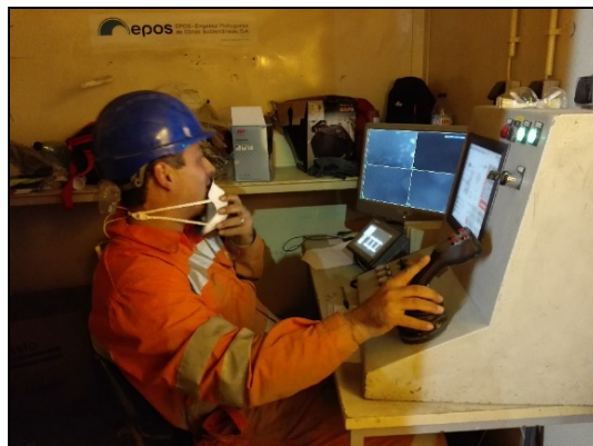
Figura 38. Operador na cabine de comando a descer o robot de projeção (arquivo de fotos EPOS SA; com autorização).
