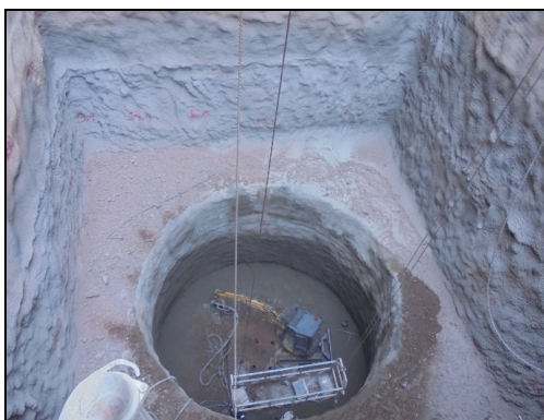
Figura 55. Projeção do poço com o manobrador no interior da miniescavadora (arquivo de fotos EPOS SA; com autorização).
