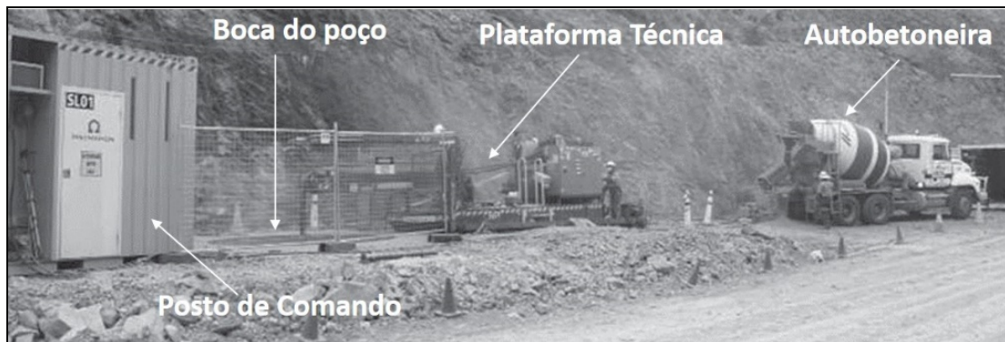
Figura 6. Sistema “Shaft Liner” instalado em funcionamento (adaptado de Ford et al., 2010).
