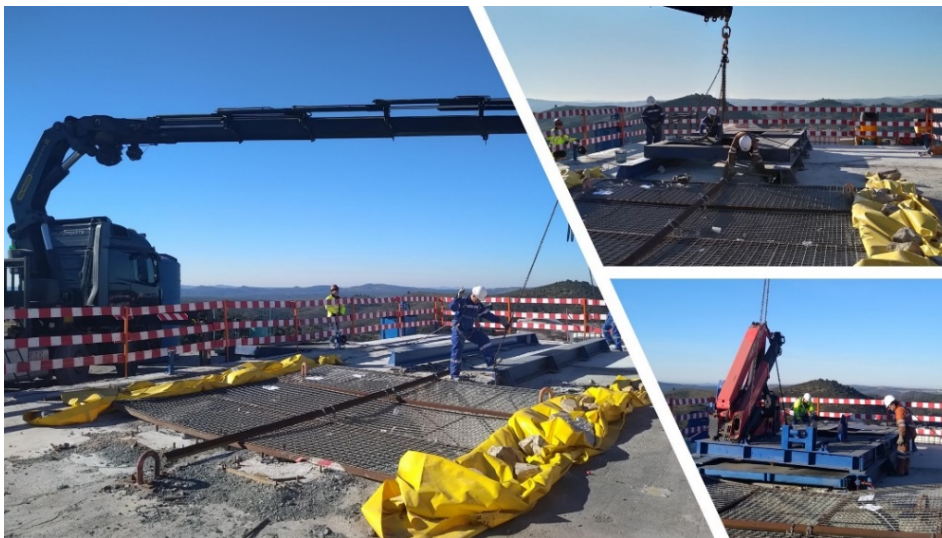
Figura 7. Montagem da plataforma técnica do “Shaft Liner” (adaptado do arquivo de fotos EPOS SA; com autorização).
