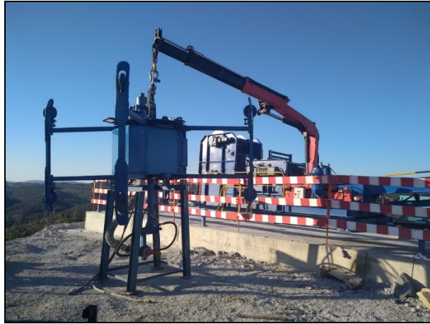
Figura 16. Robot montado no cavalete (arquivo de fotos EPOS SA; com autorização).
