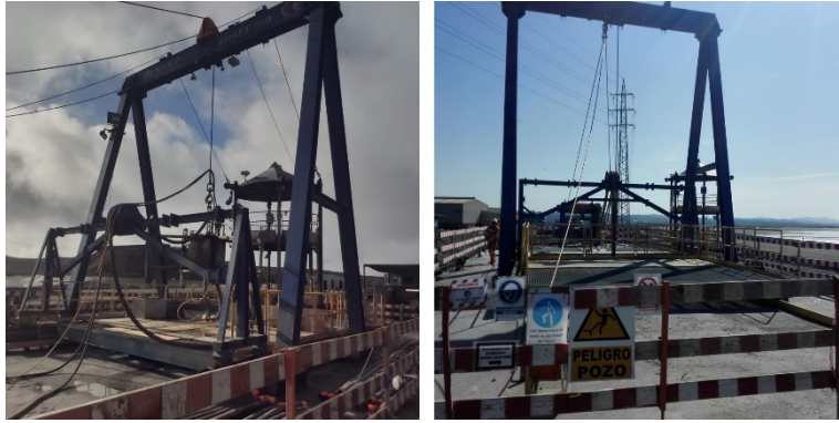
Figura 67. Estrutura montada para o poço 5 (arquivo de fotos EPOS SA; com autorização).
