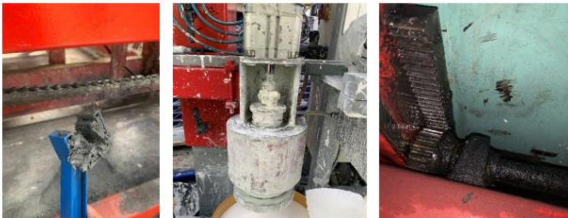
Figura 41 - Antes da implementação da manutenção autónoma das máquinas de enchimento
