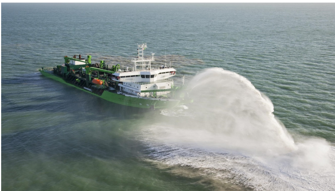
Figura 6 - Draga de sucção em marcha a realizar a bombagem do material, pertencente à empresa DEME, sendo a sua designação "Breughel" ( https://www.deme-group.com/ )
