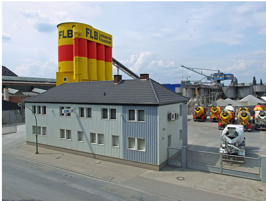
Figura 2.2: Uma central de betão pronto
