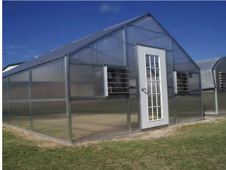
Figura 1 Estufa no formato capela [Fonte 1 ]
