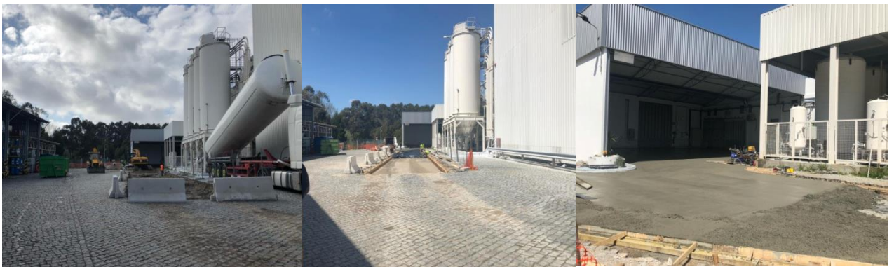
Figura 66 – Obras da pavimentação do piso para a implementação do Mizusumashi
