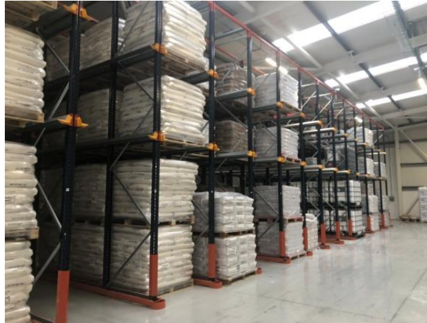
Figura 34 – Nova zona do armazém com o Drive-In de capacidade intermédia operacional
