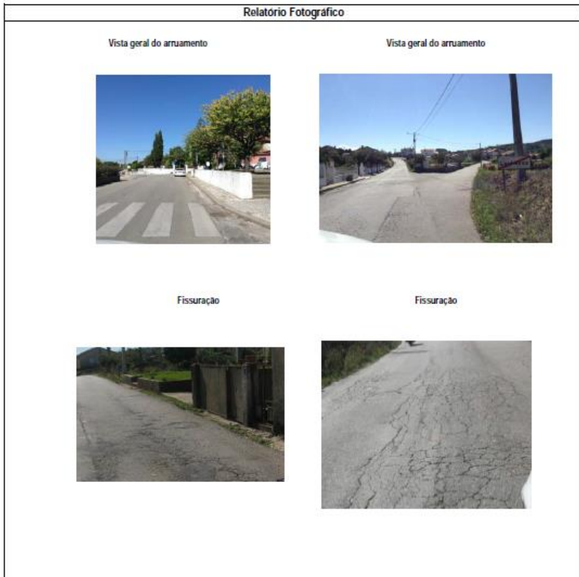
Figura 6.2 – Relatório fotográfico incluído nas fichas de vistoria.
