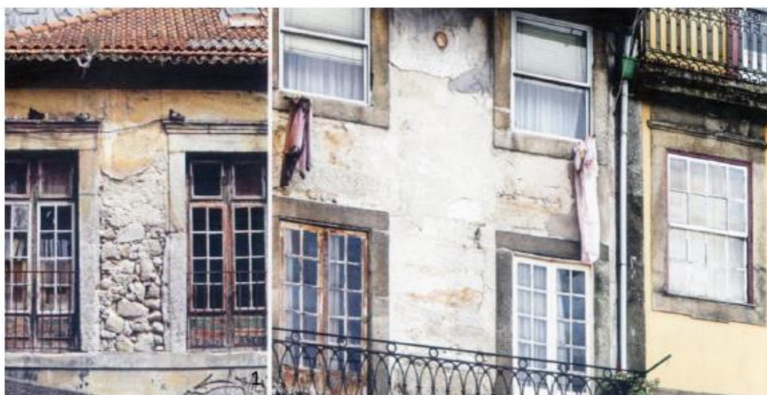
Figura 11 - Parede de fachada em alvenaria [16]
