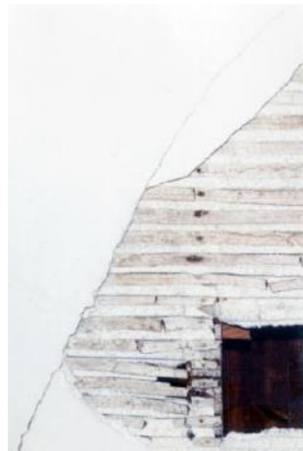
Figura 20- Destacamento do revestimento em estuque ficando visível o fasquiado e o revestimento; [16]
