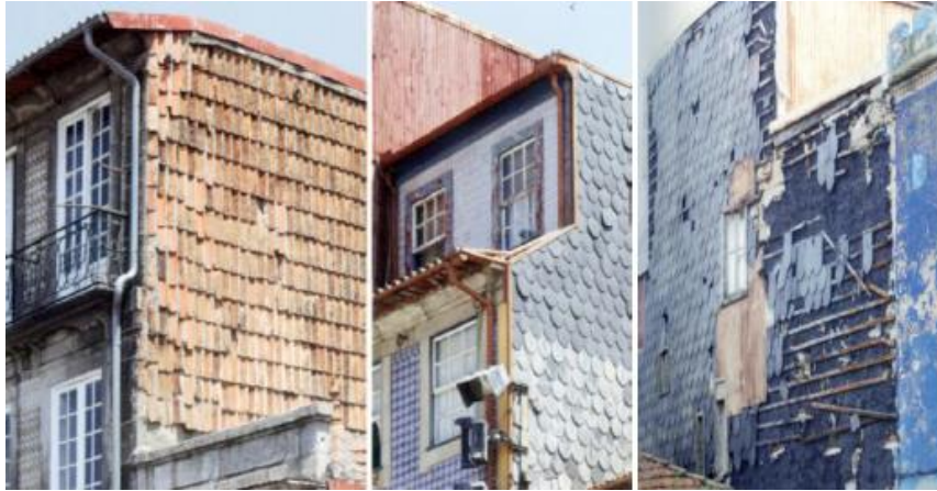
Figura 18 - Paredes de meação e revestimentos; [16];
