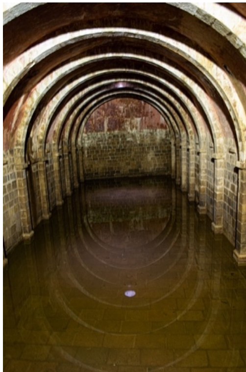
Figura 9 - Foto do interior da Cisterna de Marvão
