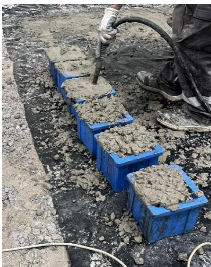
Figura 24-Foto do processo de preparação dos cubos em obra
