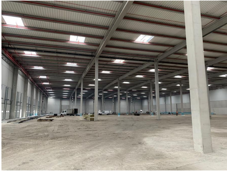
Figura 36-Foto interior do armazém
