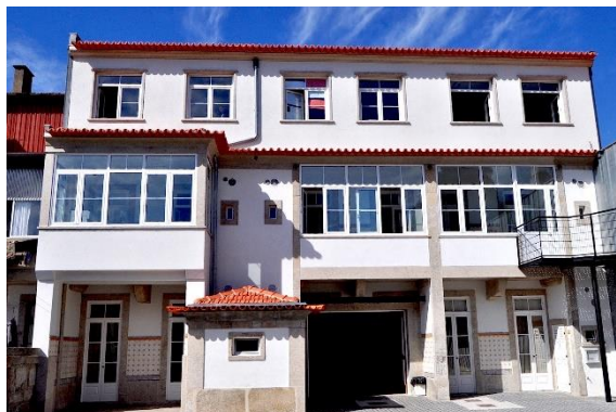
Figura 7 - Entrada interior dos edifícios 972, 982, 984
