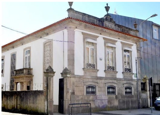
Figura 6 - Entrada do edifício 990
