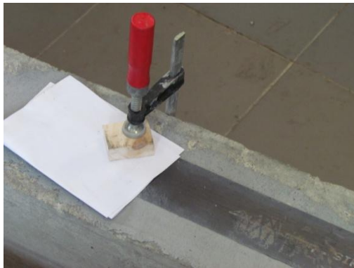
Figura 6.6 Colocação dos grampos
