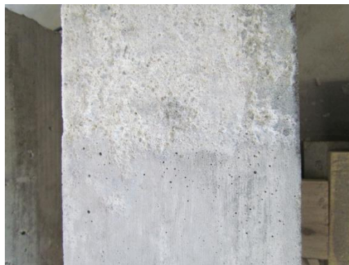
Figura 6.4 Aspeto da superfície do betão após preparação
