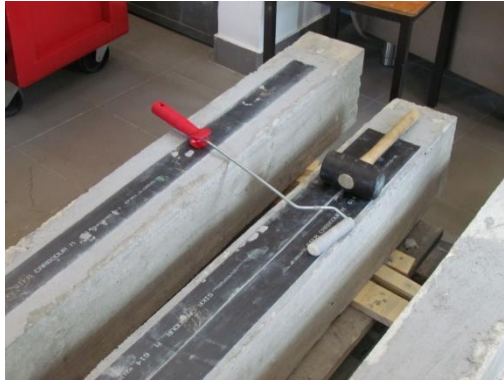
Figura 6.5 Fase final da colocação do laminado
