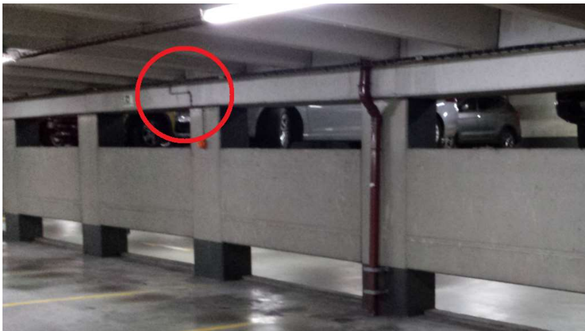
Fotografia 3.8 – Ligação viga-viga (Acervo pessoal, 2015)
