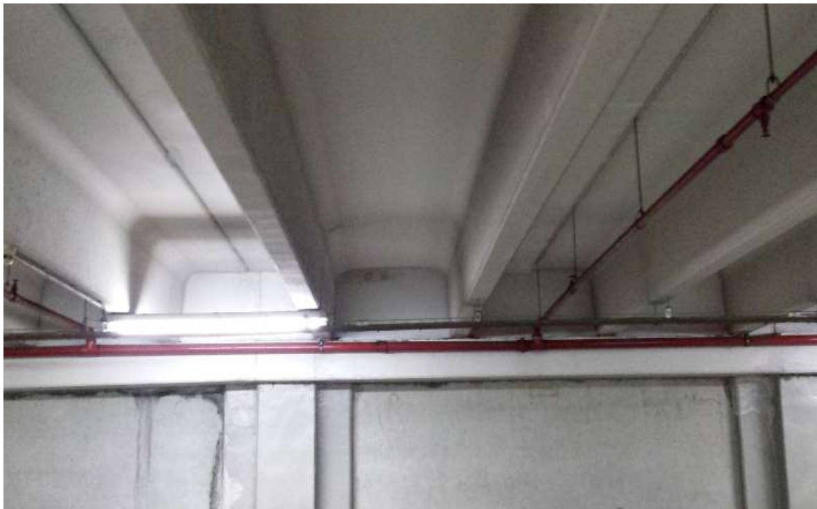
Fotografia 3.1 – Lajes “duplo T” dos pavimentos inferiores (Acervo pessoal, 2015)
