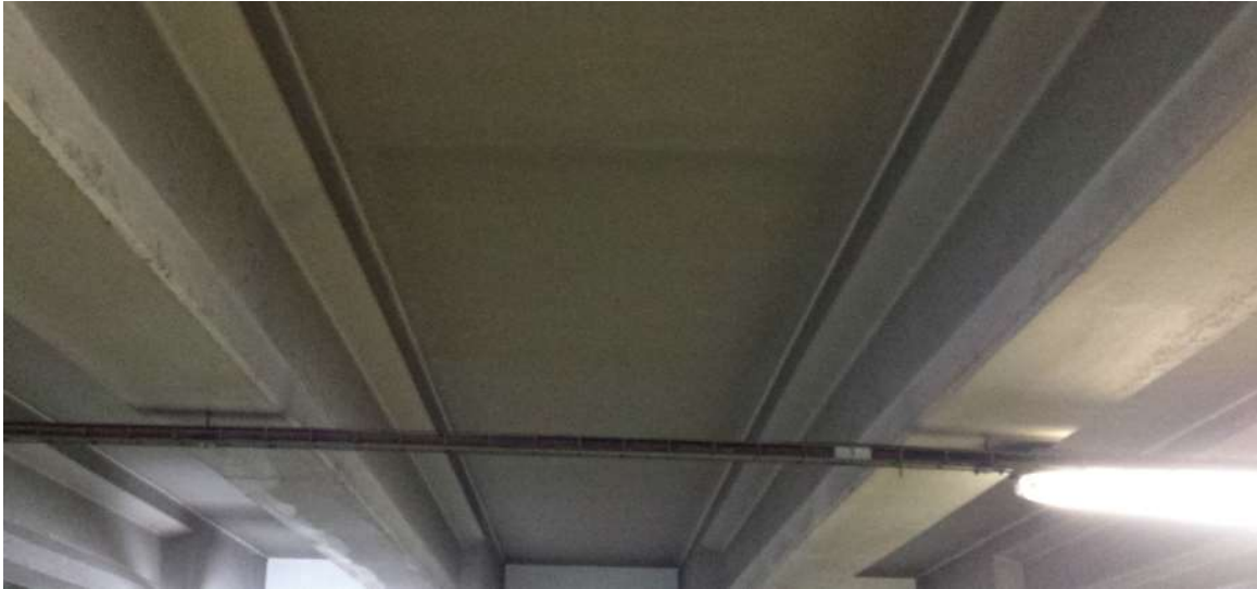
Fotografia 3.2 – Pré-lajes pré-fabricadas com vigas “I” do pavimento superior (Acervo pessoal, 2015)
