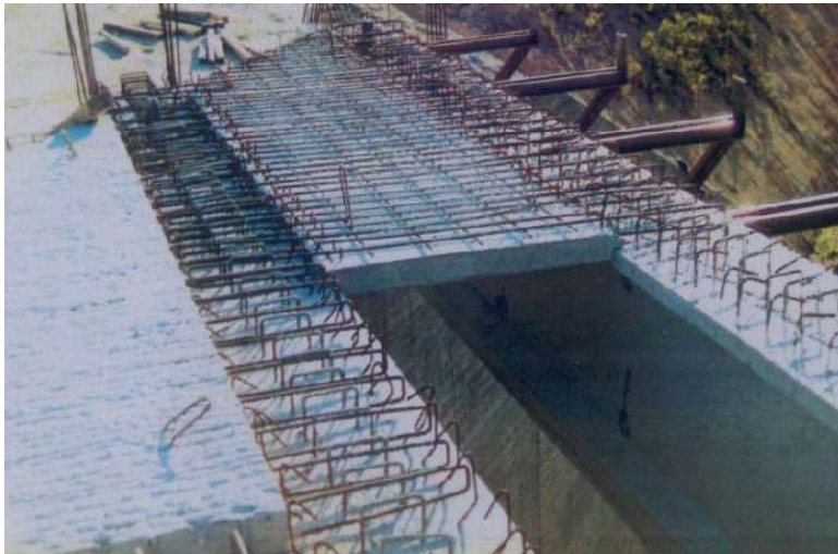
Fotografia 3.10 – Exemplo de ligação pré-laje com viga "I" sendo executada (Lello, 2015)
