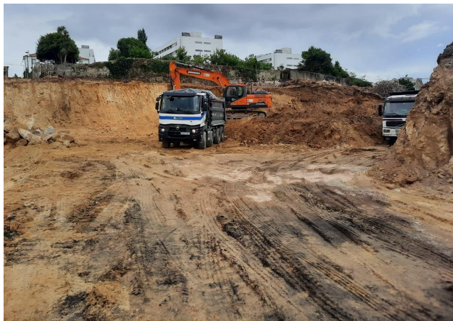
Figura 5.31 – Escavações na terceira fase, criando rampa de acesso ao ringue desportivo.
