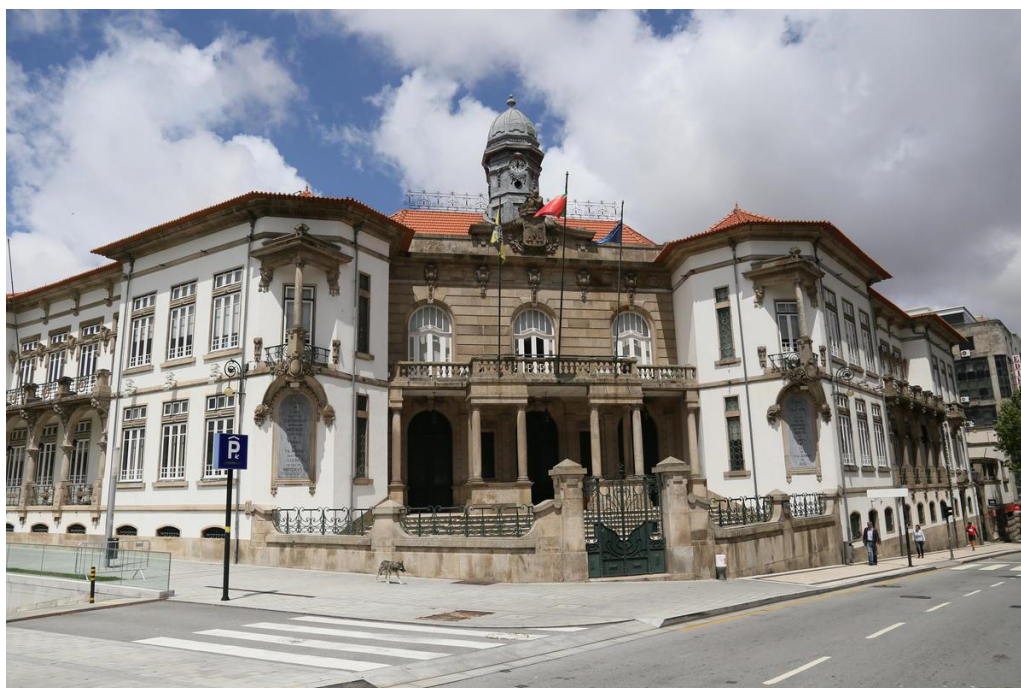
Figura 2.1 – Edifício da Câmara Municipal de Gaia [2].
