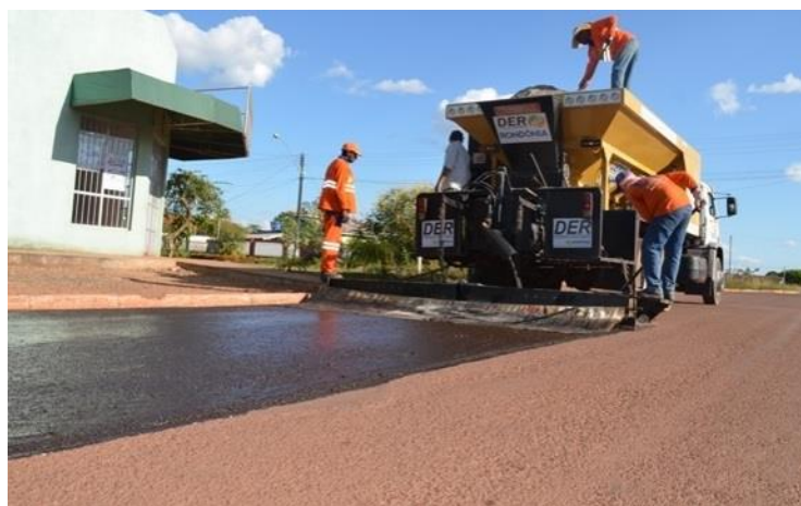
Figura 3.14 – Colocação de lama asfáltica [20].
