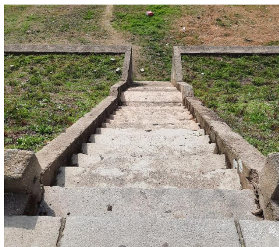
b) Escadas existentes a demolir
