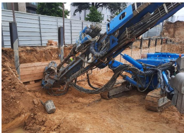
a) Processo de furação de ancoragens
