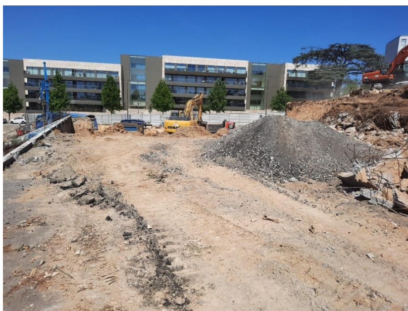
Figura 5.30 – Escavações numa segunda fase enquanto decorre a primeira.
