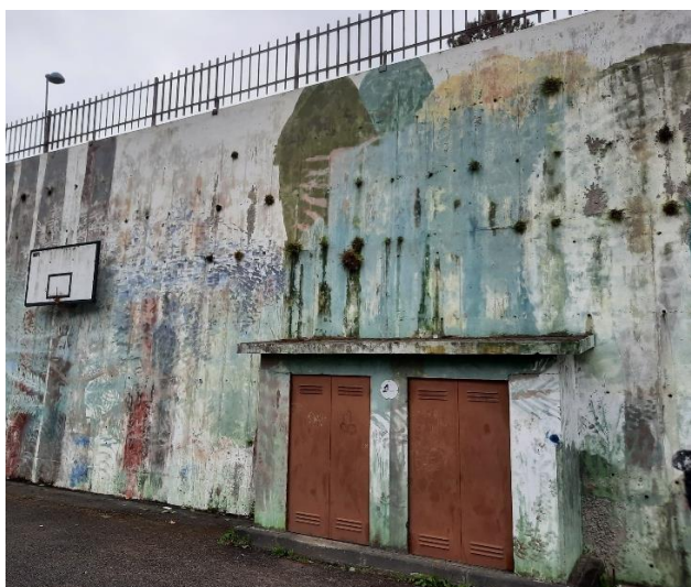
Figura 5.40 – Compartimento para armazenar as botijas de gás da escola.
