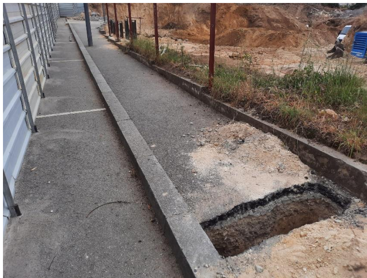
Figura 5.41 – Abertura de vala para análise da rede de iluminação pública.
