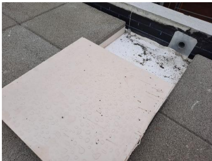
Figura 4.3 - Aplicação de laje isolante numa cobertura.
