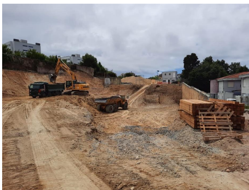
Figura 5.32 – Escavação em fase final até à cota de projeto.
