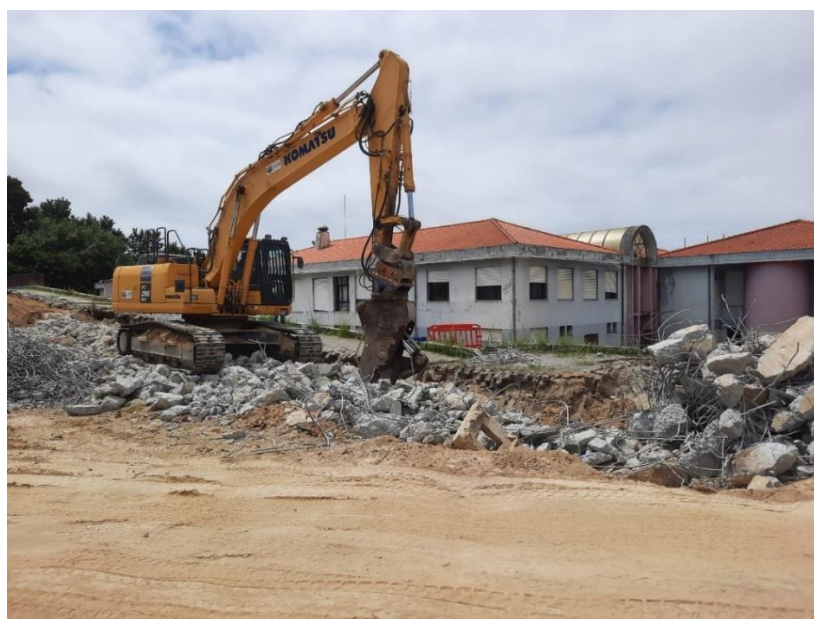
Figura 5.38 – Demolição dos muros da rampa por esmagamento com recurso a tesoura hidráulica.
