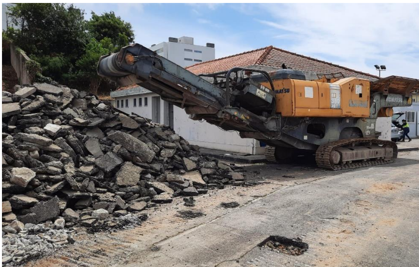
Figura 5.27 – Máquina de britagem móvel para demolição do pavimento em betão betuminoso.
