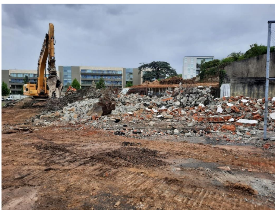
Figura 5.33 – Demolição do balneário existente através de esmagamento por tesoura hidráulica.
