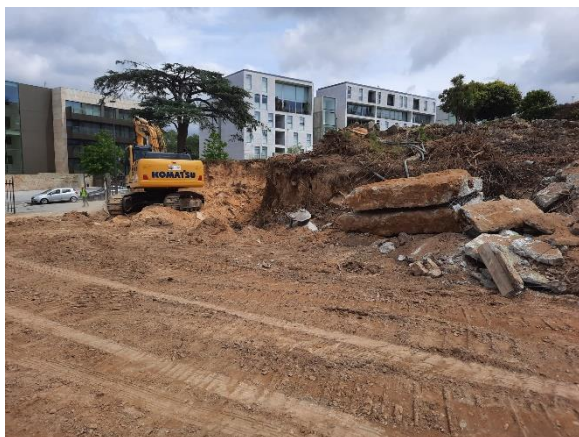
a) Início das escavações
