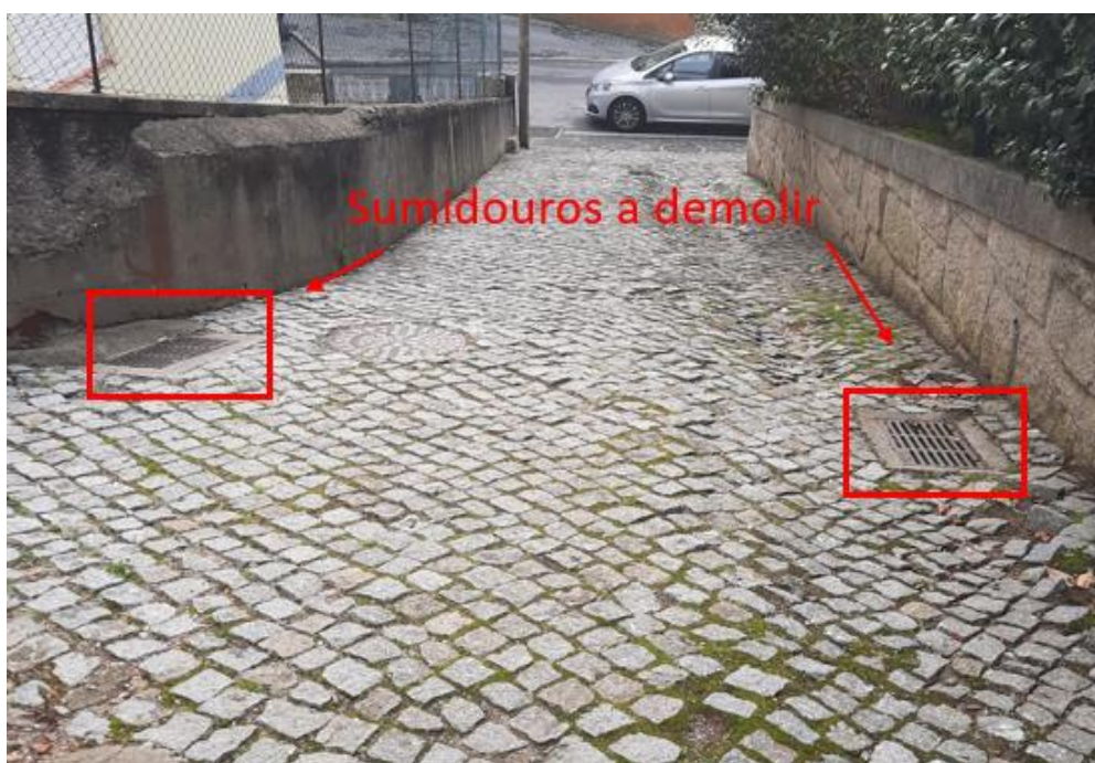
Figura 5.13 – Localização dos outros dois sumidouros a demolir.
