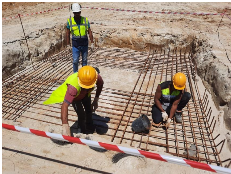
Figura 5.39 – Execução da sapata perdida da grua.
