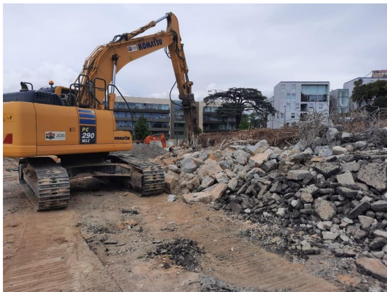
Figura 5.37 – Demolição do muro a cota alta por esmagamento com recurso a tesoura hidráulica.
