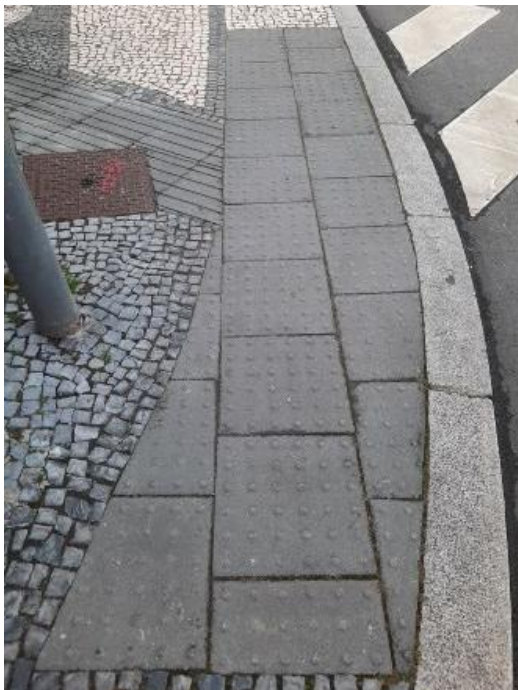
Figura 4.2 – Passadeira para invisuais com pavé estriada e pitonada.
