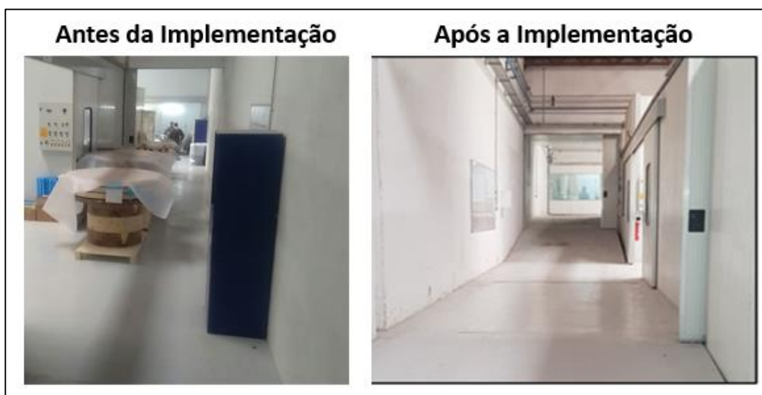
Figura 60. Corredor Central- Acabamentos
