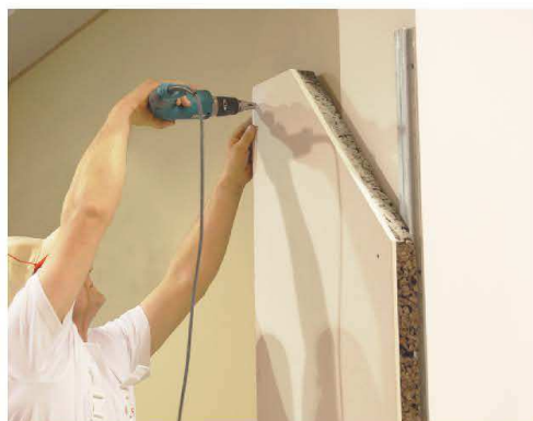
Figura 2: Aplicação da placa composta de gesso laminado com isolamento incorporado em aglomerado de cortiça expandida
