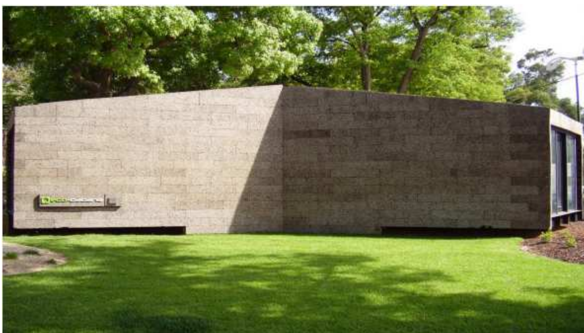
Figura 4. 8 - Revestimento exterior em MDFACHADA : Ecocabana , Cascais. (Facultado por Amorim Isolamentos, S.A. , 2013).
