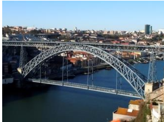
Figura 3 - Ponte D. Luís, Porto. Obra de arte treliçada [9].
