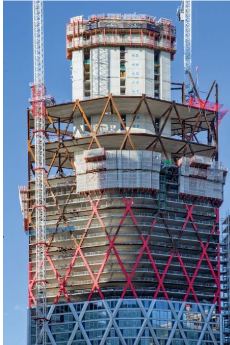
Figura 1 - Construção de uma torre em Canary Warf, Londres [6].
