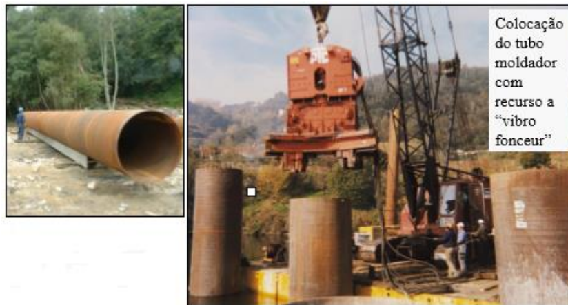
Figura 3.13 - Execução de estacas moldadas com tubo moldador perdido. (Pinto, 2006)
