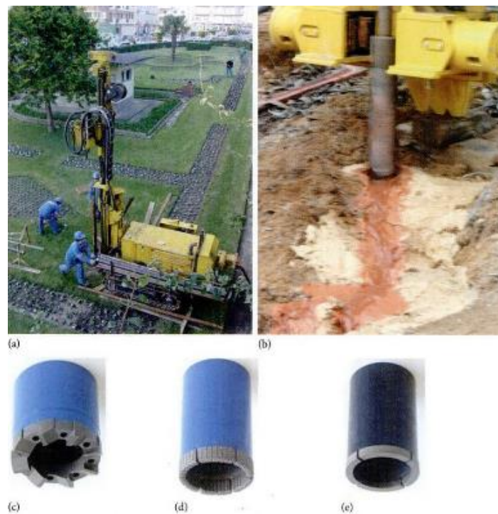
Figura 2.3 - Sondagem à rotação (fotografia de Nuno Cruz): a) vista geral; b) equipamento em laboração; c) coroa de carboneto de tungsténio; d) coroa diamantada incrustada; e) coroa diamantada impregnada.
