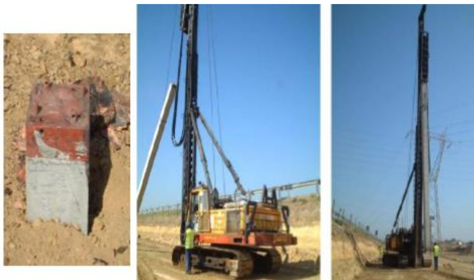
Figura 3.10 - Da esquerda para a direita: cabeça da estaca com dispositivo de ligação (colar metálico e pino); posicionamento do equipamento; verticalização da estaca. (Pinto, 2006)
