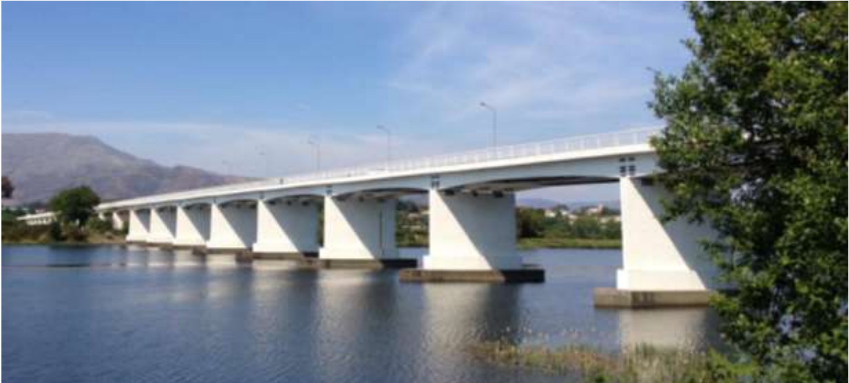
Figura 3.3 - Vista geral da Ponte de Lanheses.
