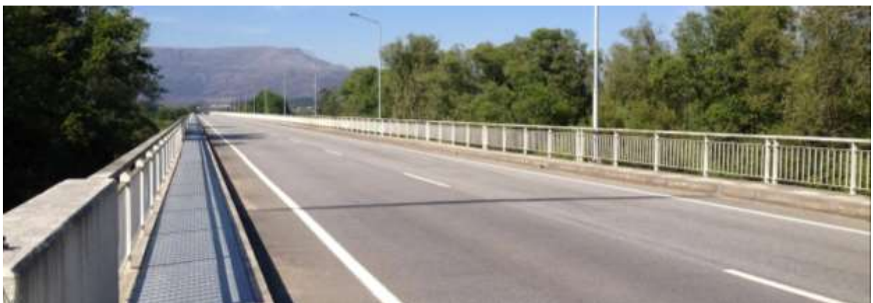
Figura 3.4 - Tabuleiro da Ponte de Lanheses.
