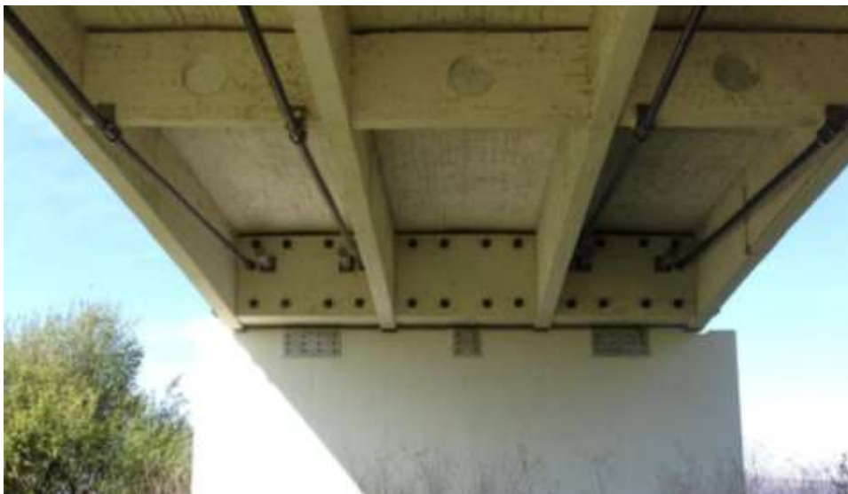
Figura 3.6 - Vista inferior da ponte.
