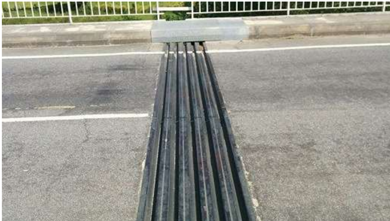
Figura 3.5 - Junta de dilatação do encontro móvel.
