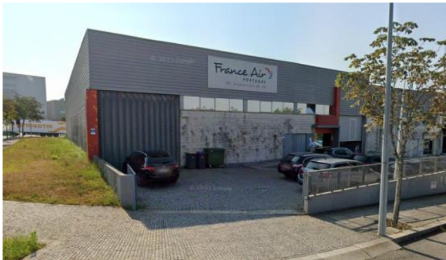
Figura 2 – Escritório do Porto retirado do Google Maps 2024
