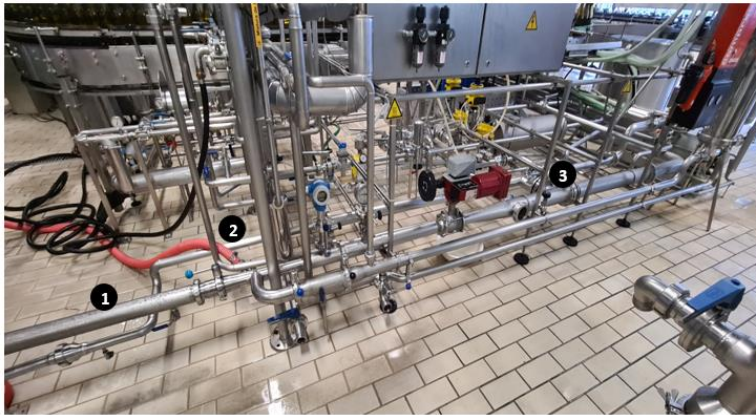
Figura 4. 10 – Sistema de alimentação da cuba da enchedora.
