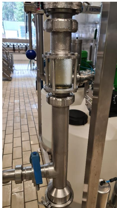
Figura 4. 7 – Ponto de inspeção da linha 3.
