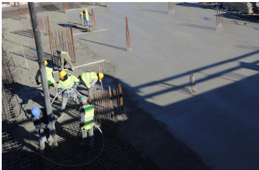
Figura 3.35 – Armaduras de arranque de pilares num ensoleiramento.
