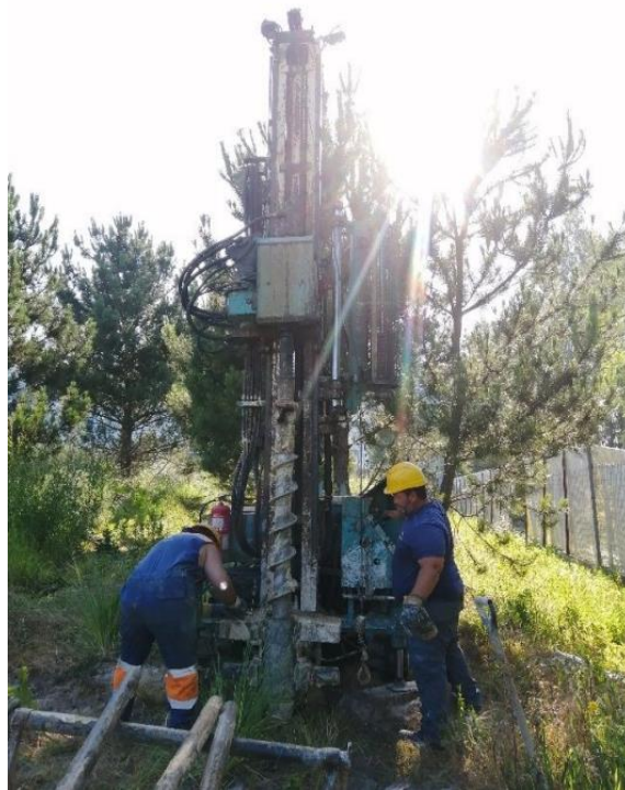
Figura 4.1 – Execução de uma sondagem (Triáguas, 2021).
