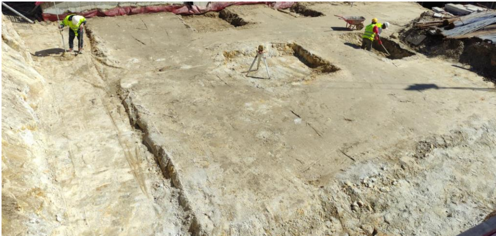
Figura 4.7 – Área de escavação do ensoleiramento.
