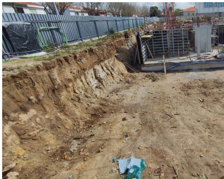
Figura 4.6 – Talude de escavação.
