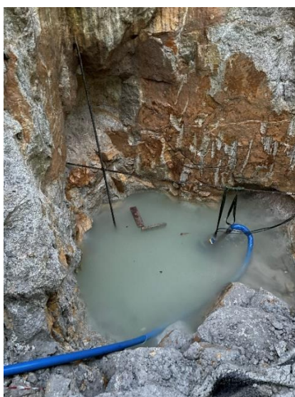
Figura 3.27- Drenagem do terreno recorrendo a uma bomba de água.
