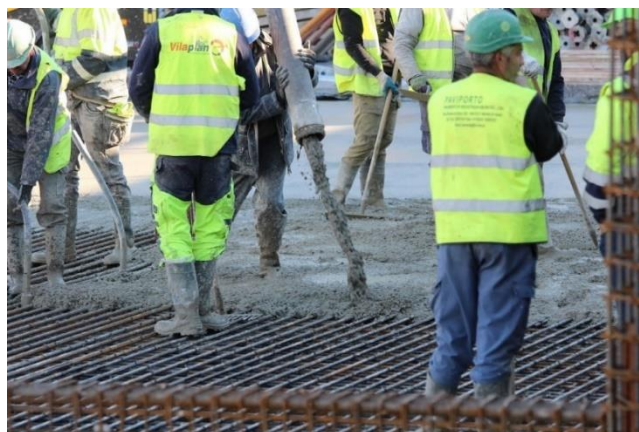
Figura 4.10 – Betonagem.
