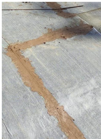
Figura 4.8 - Tela betonítica impermeável do tipo Voltex.
