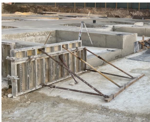
Figura 3.33 – Pormenor do escoramento de uma cofragem.
