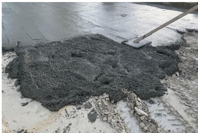
Figura 3.28 – Aplicação de betão de limpeza.
