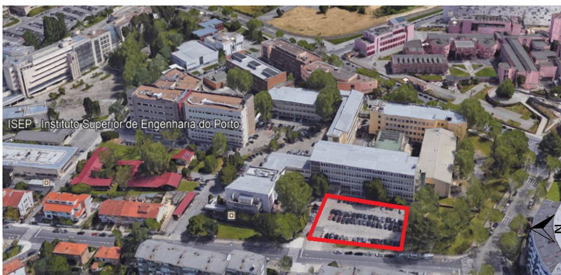
Figura 49 – Imagem do local onde se vai situar o edifício.
