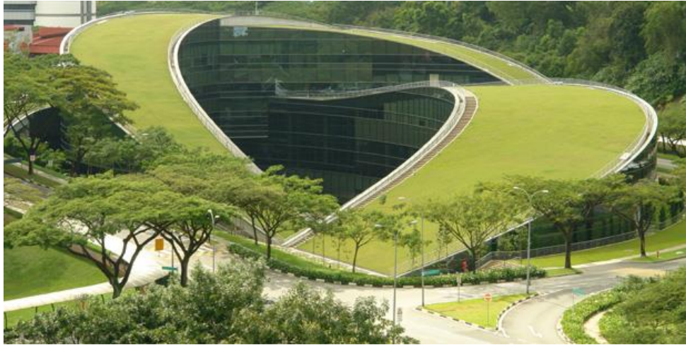
Figura 17 – Cobertura verde da escola de Arte, Design e Comunicação da Universidade de Nanyang, em Singapura.
