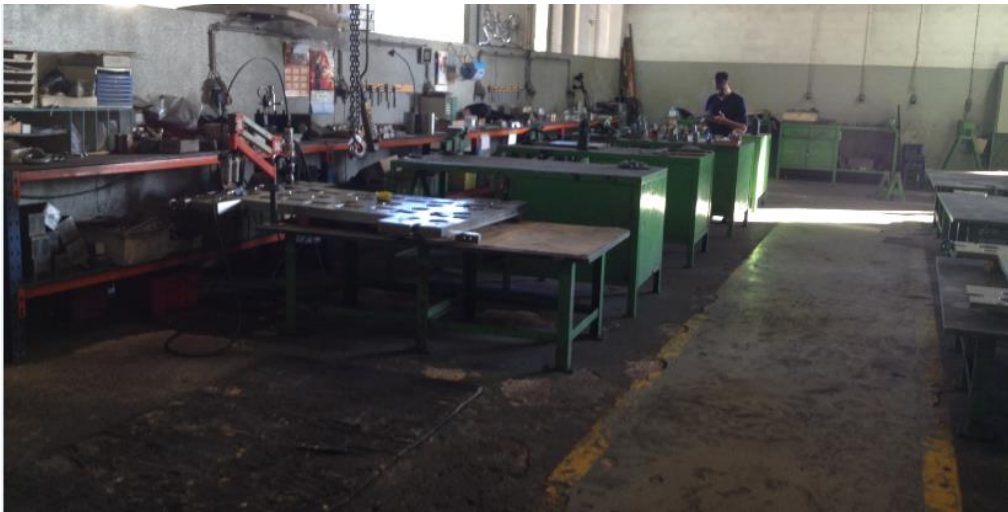
Figura 27 - Estado inicial das bancadas
