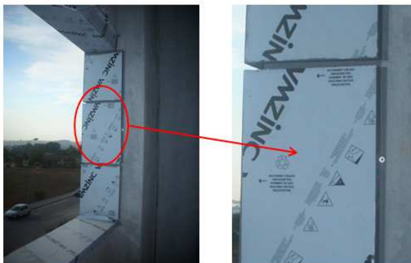
Figura 124 - Pormenor de remate lateral (Orientação: Sudoeste)
