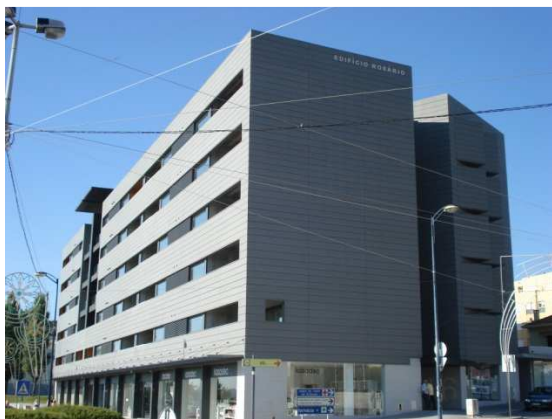
a) Fachada Sudoeste e Sudeste
