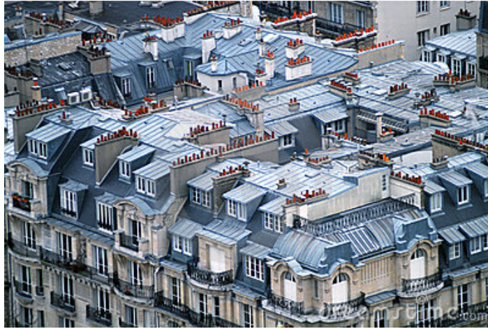
Figura 13 - Telhados de Paris [3]
