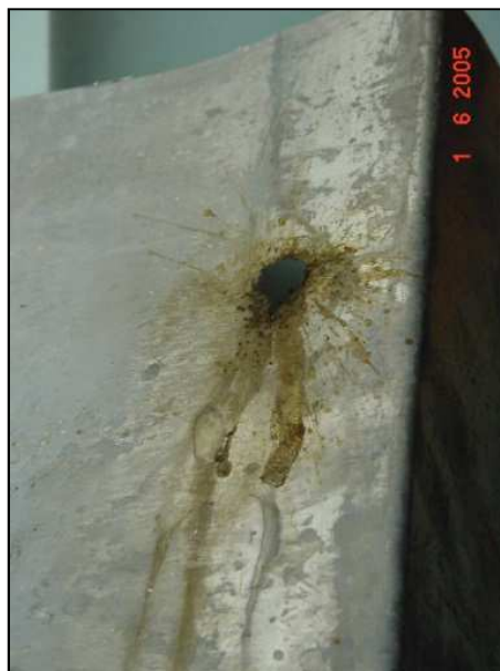
Figura 97 - Orifício provocado pelo ataque químico de ácidos
