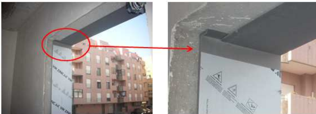
Figura 122 - Pormenor de remate lateral e da padieira (Orientação: Nordeste)
