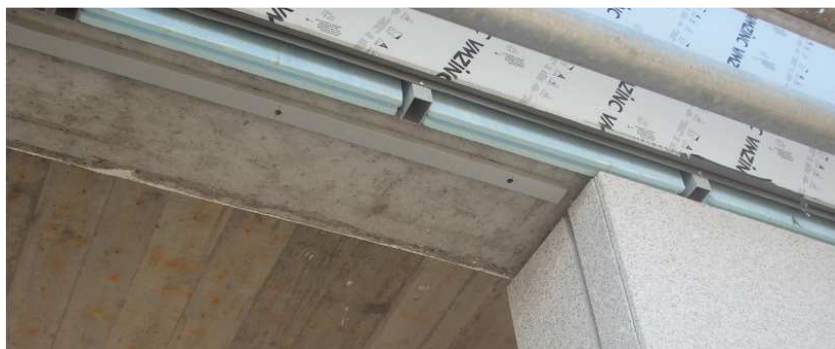
Figura 116 – Pormenor da instalação dos painéis sobre o isolante térmico
