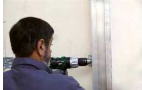
Fase 1- Fixação das calhas e dos esquadros
