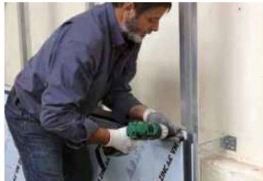
Fase 3 – Fixação do perfil à estrutura
