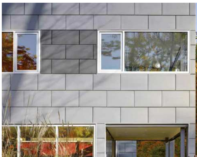
Figura 85 - Fachada de edifício revestido com cassetes do tipo “Mosaik” [6]
