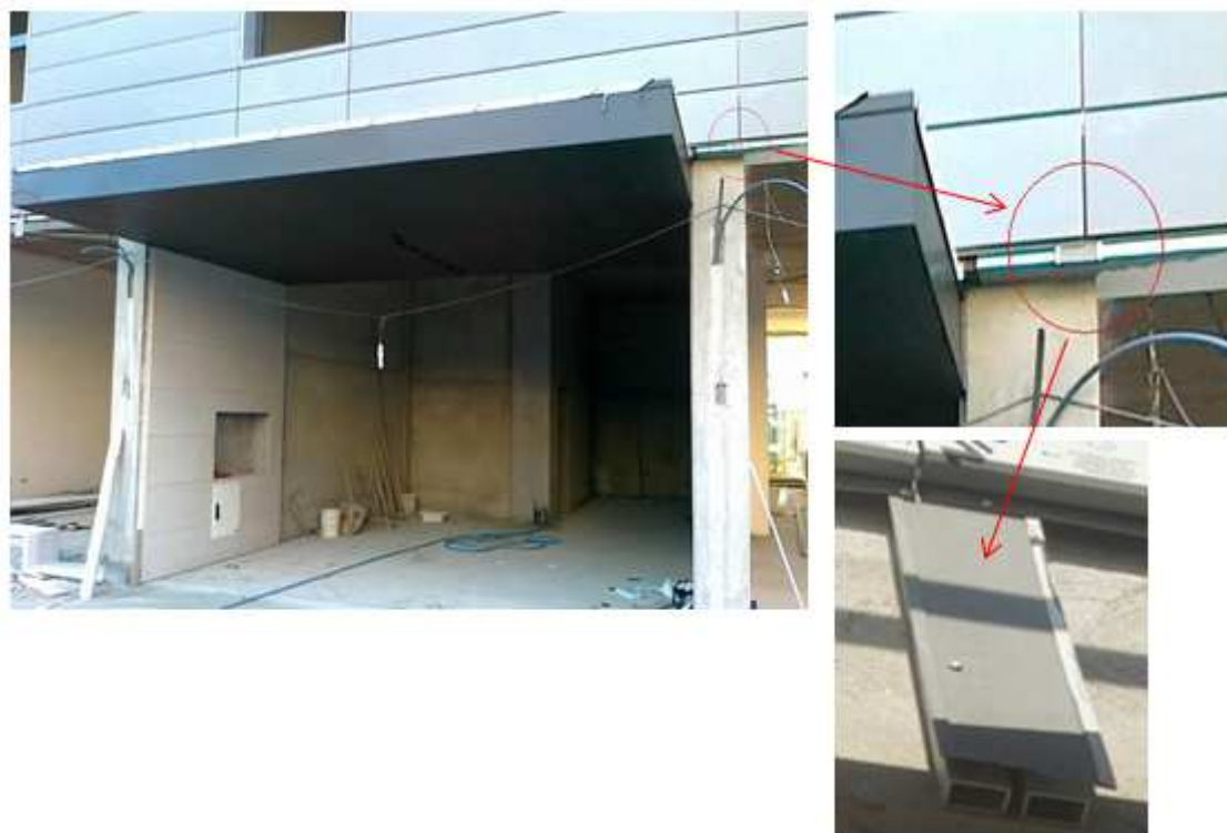
Figura 117 - Pormenor de instalação do tapa juntas na junta transversal entre painéis
