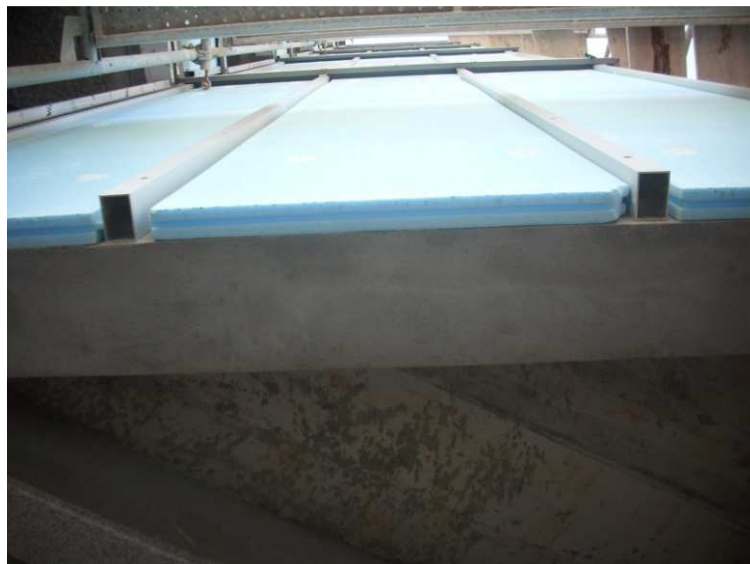
Figura 114 - Pormenor da ossatura e do isolante térmico
