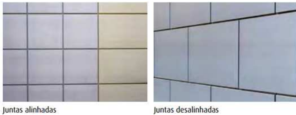
Figura 86 - Tipos de juntas [6]
