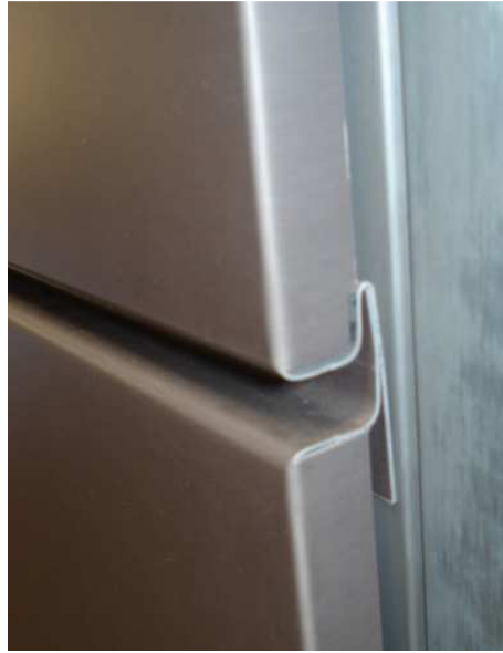
Figura 102 - Possível local de estagnação de água
