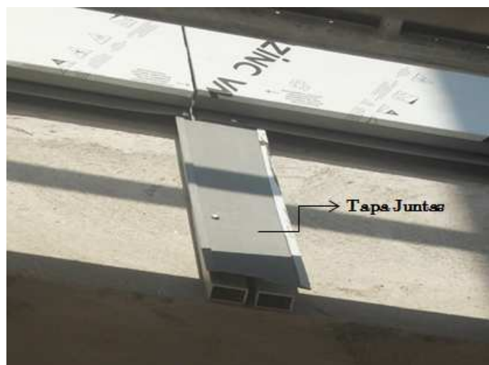
Figura 49 - Tapa juntas para união transversal para painéis horizontais
