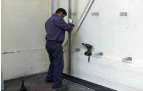
Fase 1- Fixação das calhas e dos esquadros
