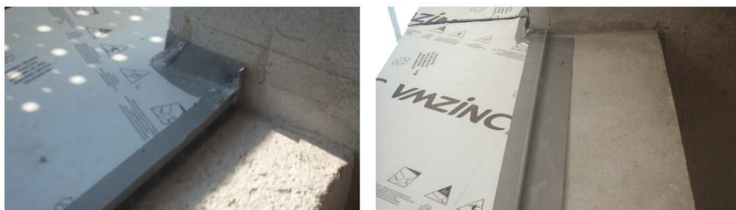
Figura 120 - Pormenor de remate da soleira da janela (Orientação: Sudoeste)
