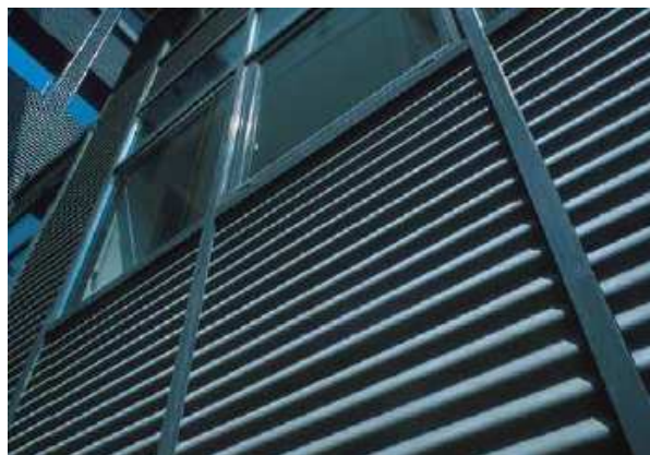
Figura 59 - Fachada de um edifício revestido a perfil de zinco ondulado [6]
