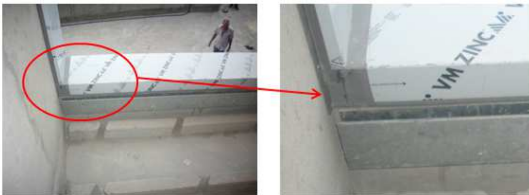
Figura 123 - Pormenor de local para posterior encaixe do guarda-corpo de vidro
