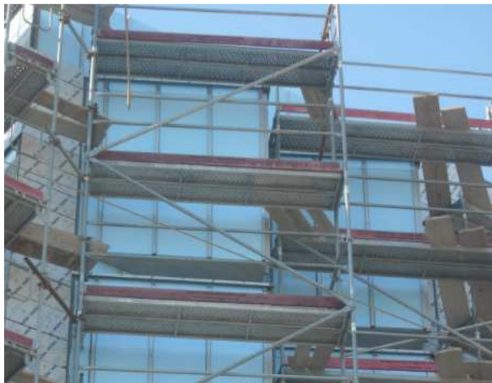
b) Colocação dos painéis de zinco nas restantes fachadas
