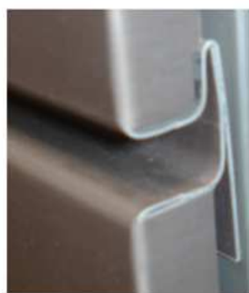
Figura 47 - Pormenor de encaixe entre painéis [6]
