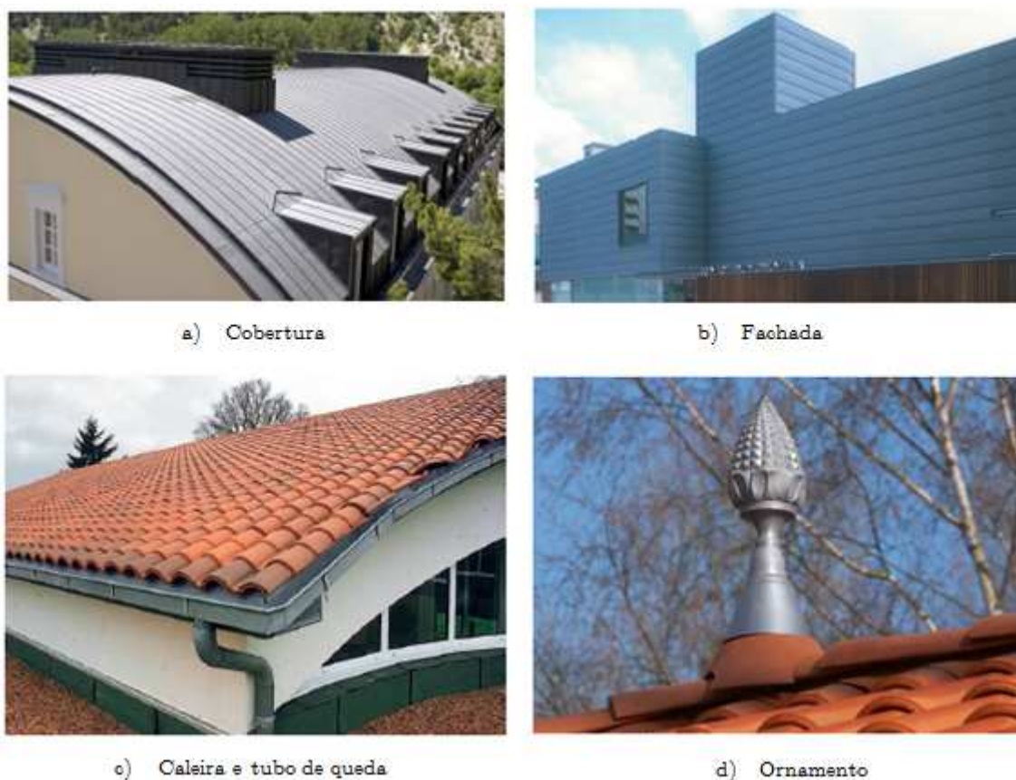
Figura 14 - Exemplos de aplicação do zinco na construção [6]
