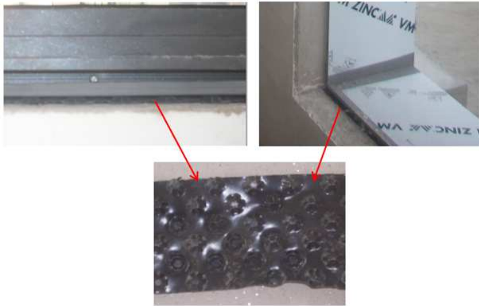
Figura 118 – Exemplo de locais de aplicação da tela pitonada em PEAD
