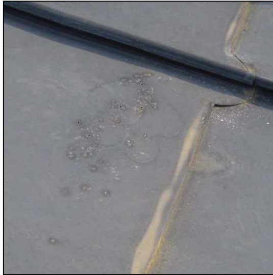
Figura 96 - Orifícios na chapa de zinco
