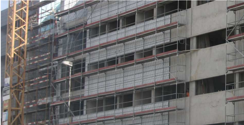
a) Colocação dos painéis de zinco na fachada principal do edifício (Sudoeste)
