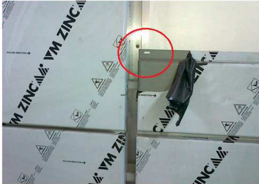
Figura 48 - Furo ovalizado em painel
