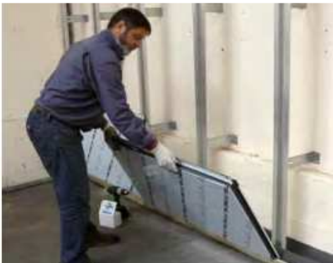
Fase 3 – Fixação do perfil à estrutura
