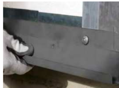
Fase 2 – Colocação e fixação do acabamento inferior
