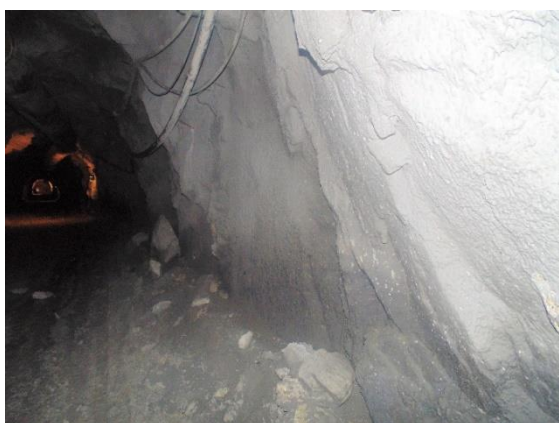
Figura 53 – Betão projetado entre os 154,2m e os 175,1 m relativamente à origem
