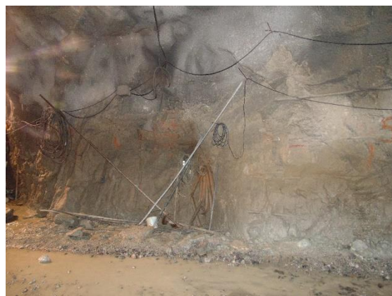
Figura 56 - Zona de interseção entre o túnel para jusante e o túnel para montante com betão projetado entre os 244 m e os 260 m relativamente à origem
