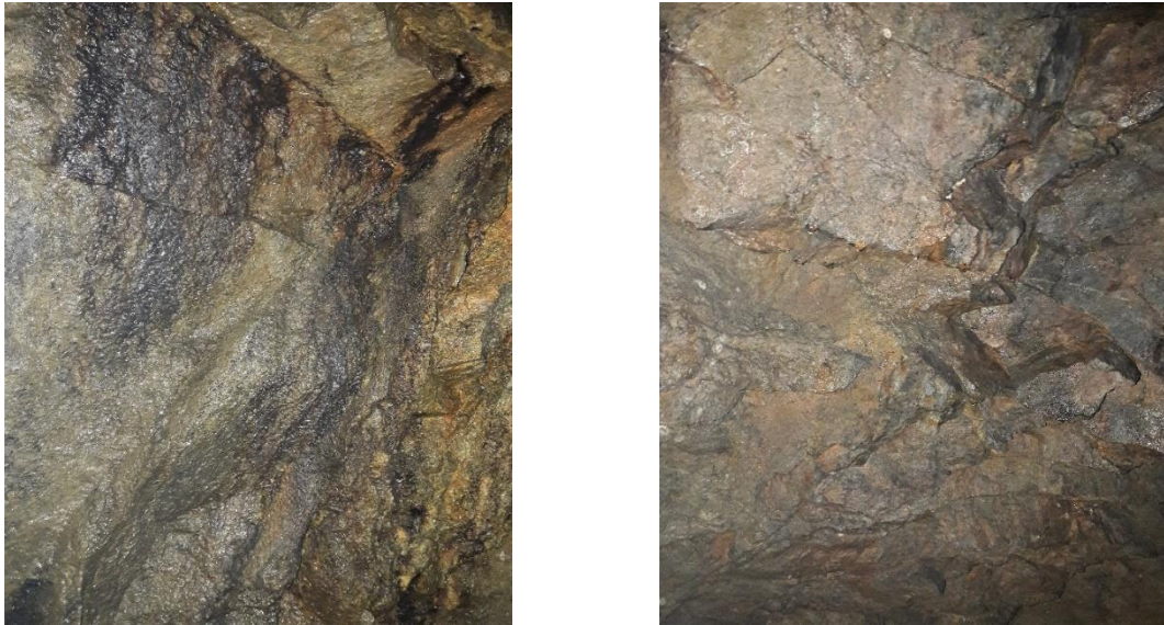
Figura 37 – Representação do maciço rochoso numa área iniciação de contacto litológico apresentando-se bastante alterado
