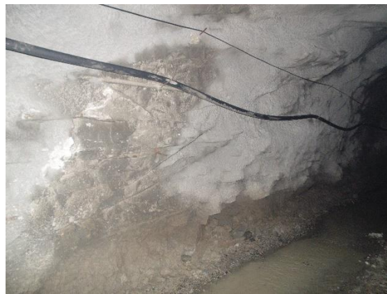
Figura 54 - Betão projetado entre os 219,5m e os 242,8 m relativamente à origem
