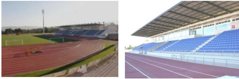
Figura 1: Estádio Municipal de Fátima com a pista de atletismo em tartan e relvado natural (à esquerda). Bancadas com lotação de 1540 lugares (à direita).
