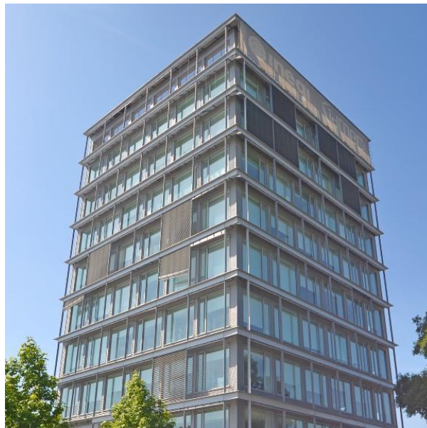
Figura 3 - Edifício do INEGI
