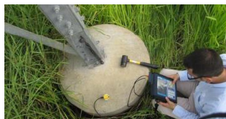
Figura 6. Avaliação da integridade da fundação com TD
