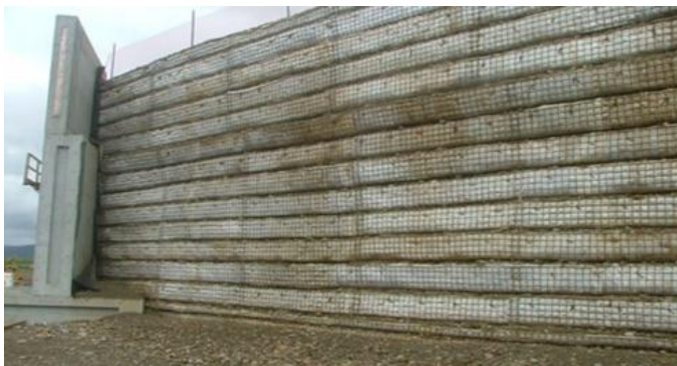
Figura 23: Muro reforçado com geotêxtil
