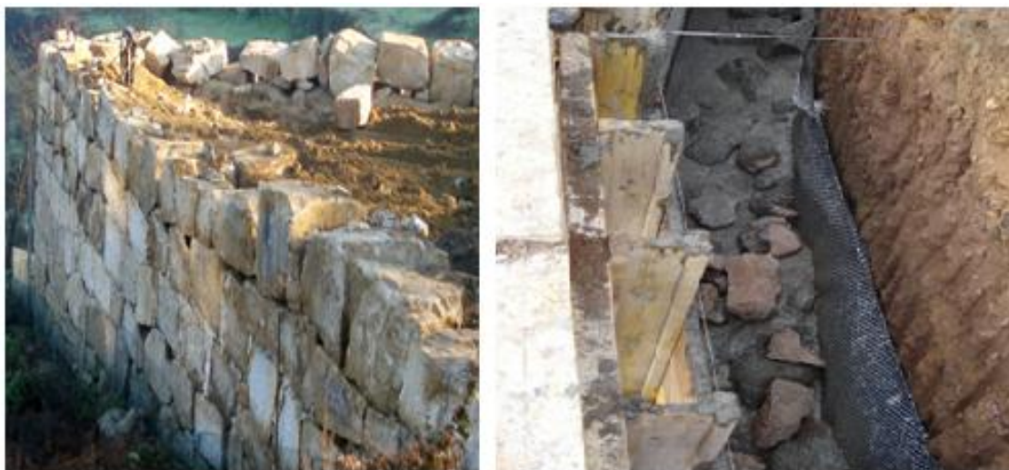
a) Muro de alvenaria de pedra
