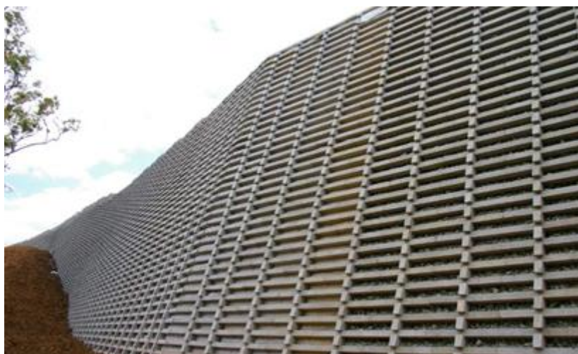
Figura 22: Muro “crib wall” de elementos pré-fabricados de betão armado
