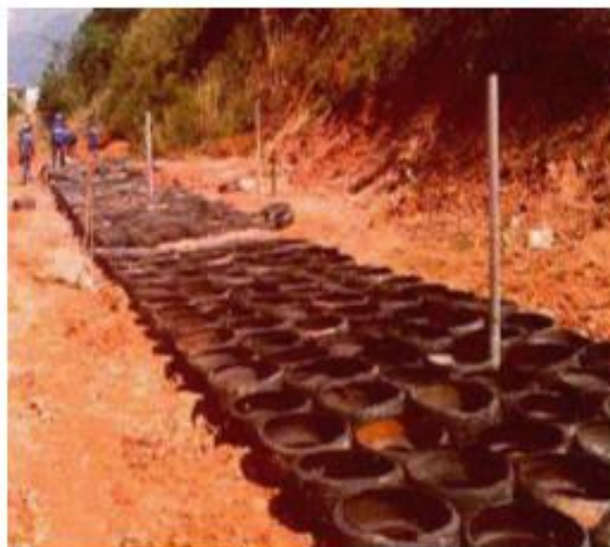
c) Colocação das camadas de pneus
