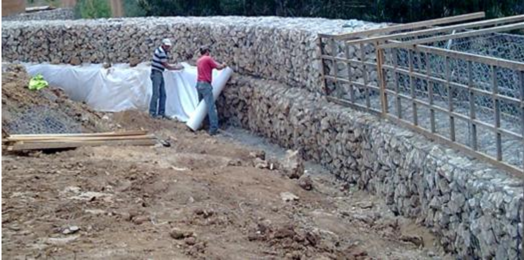
Figura 19: Construção de um muro de gabião
