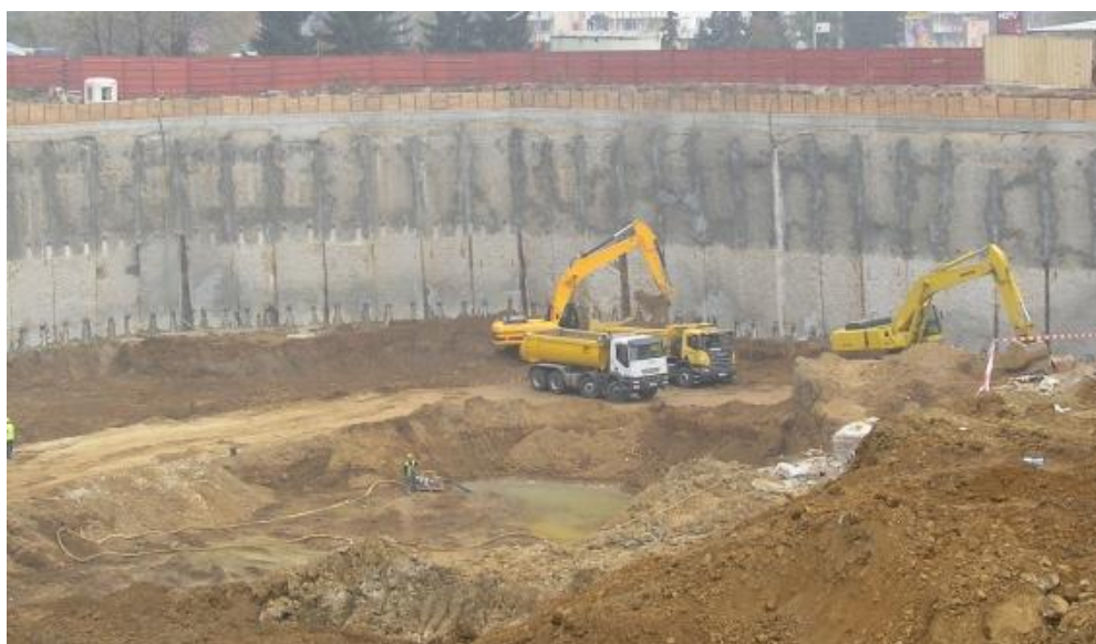
Figura 14: Parede moldada em betão armado
