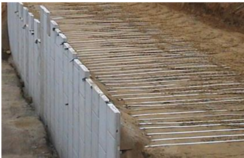
Figura 20: Construção de um muro de terra armada
